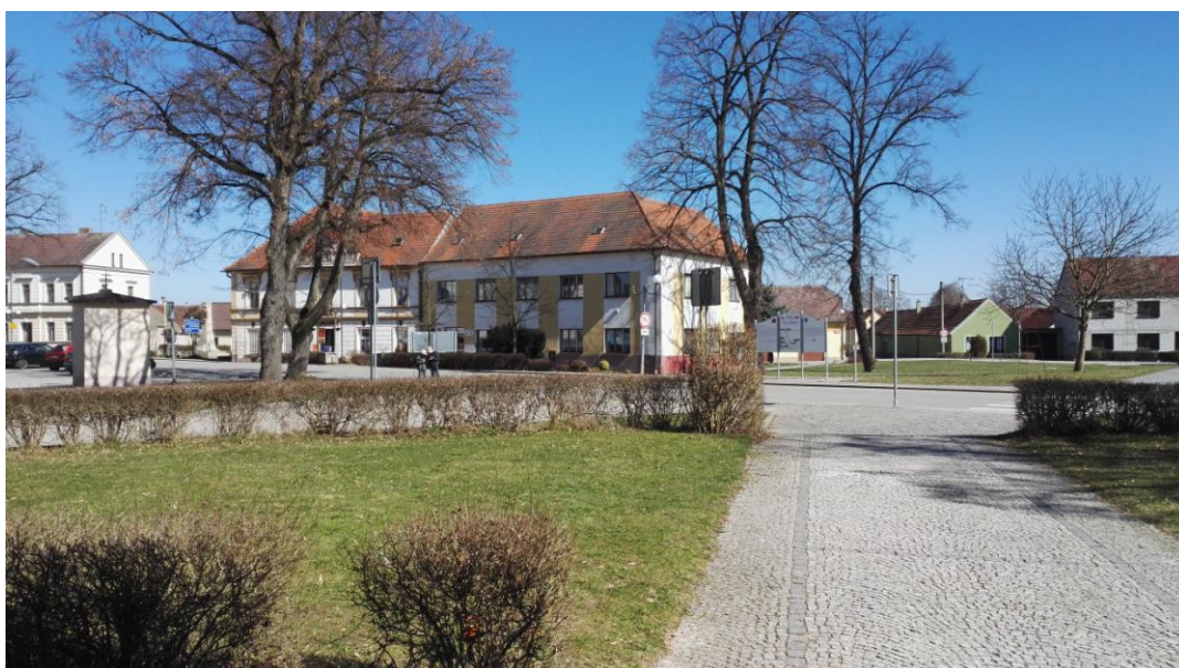
Obrázek 32 - Pohled z východní strany budovy
