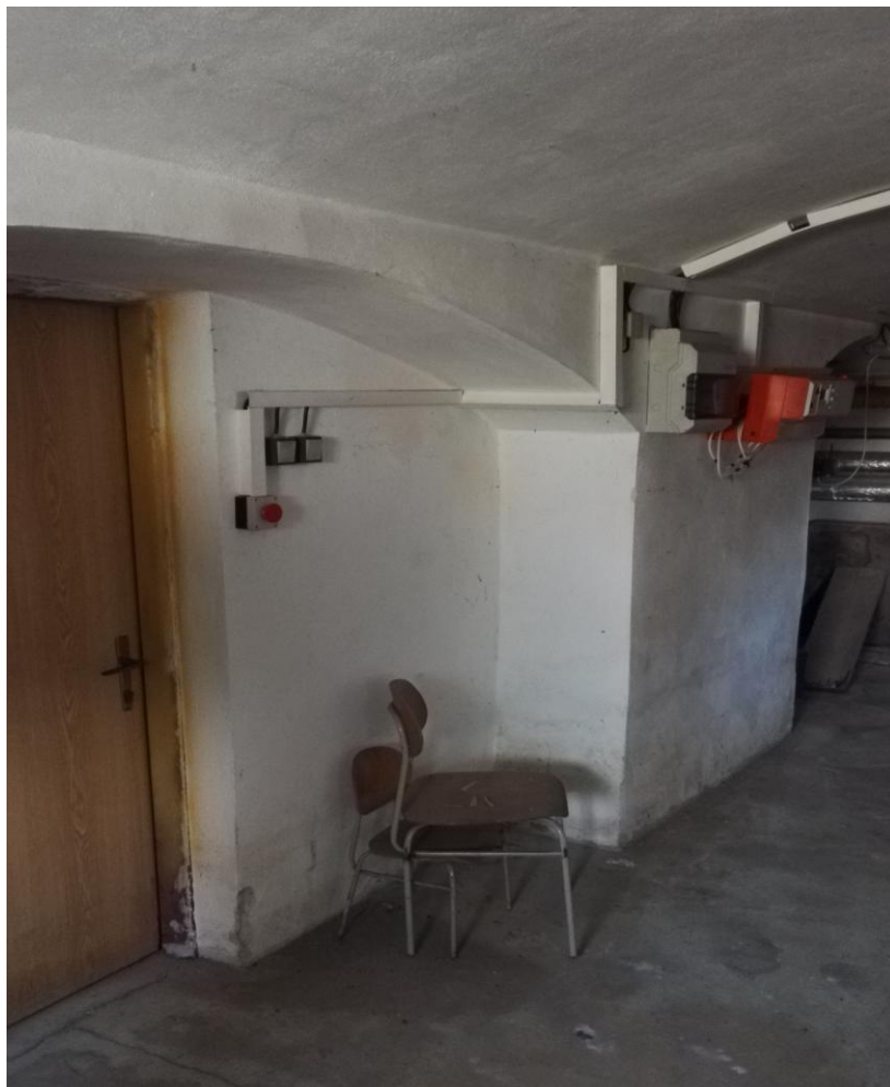
Obrázek 4 - Přistavěná dělicí příčka v podzemním podlaží objektu
