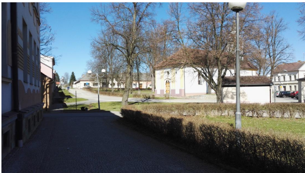
Obrázek 31 - Pohled z východní strany budovy
