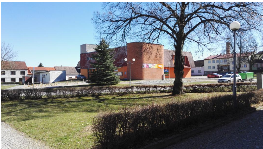
Obrázek 33 - Pohled z východní strany budovy
