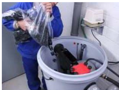
Obr. 9 – Technik přidává do bioreaktoru nosiče biomasy.
