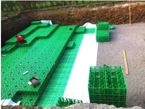
↑Obr.16 – Schéma konstrukčního řešení uložení vsakovacích boxů
