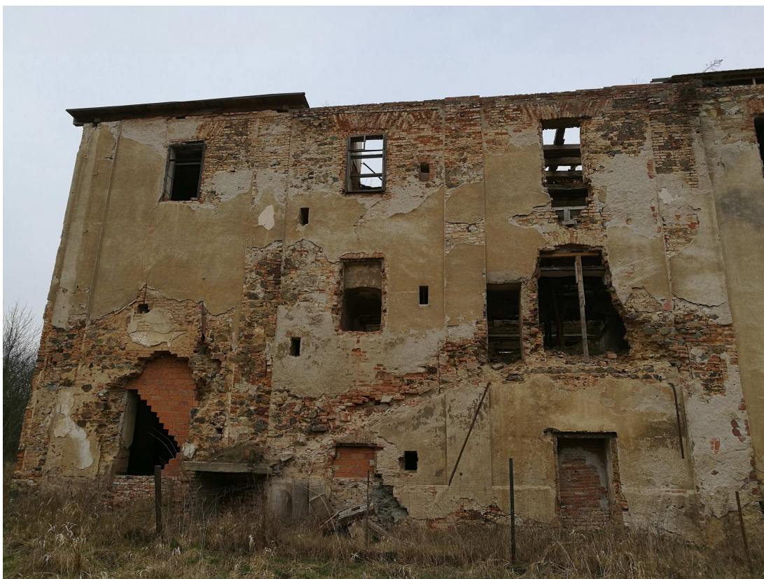
Obr. 15 Jihovýchodní pohled s schodišťovou podestou a uložením schodiště
