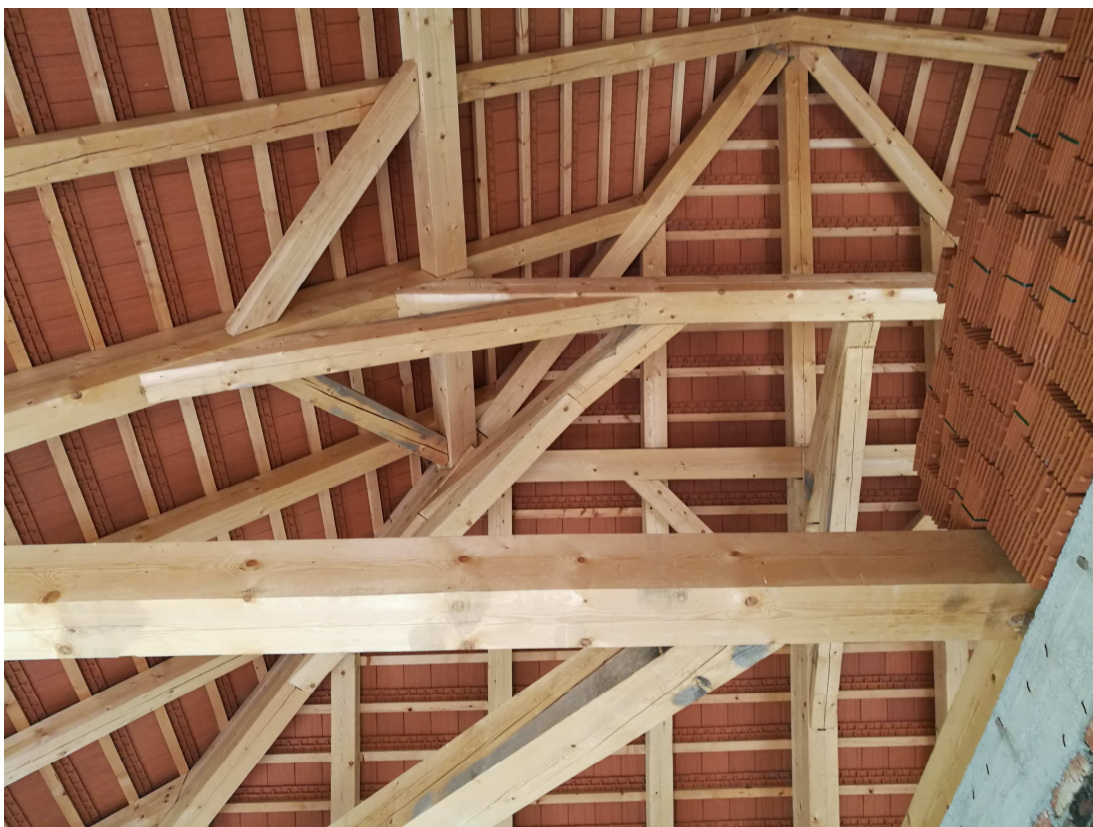
Obr. 16 Rekonstrukce části krovu
