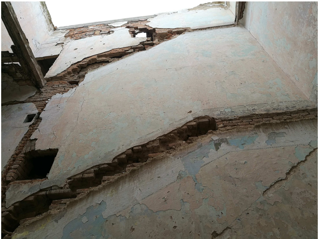
Obr. 14 drážky ve zdivu od původního osazení vnitřního schodiště
