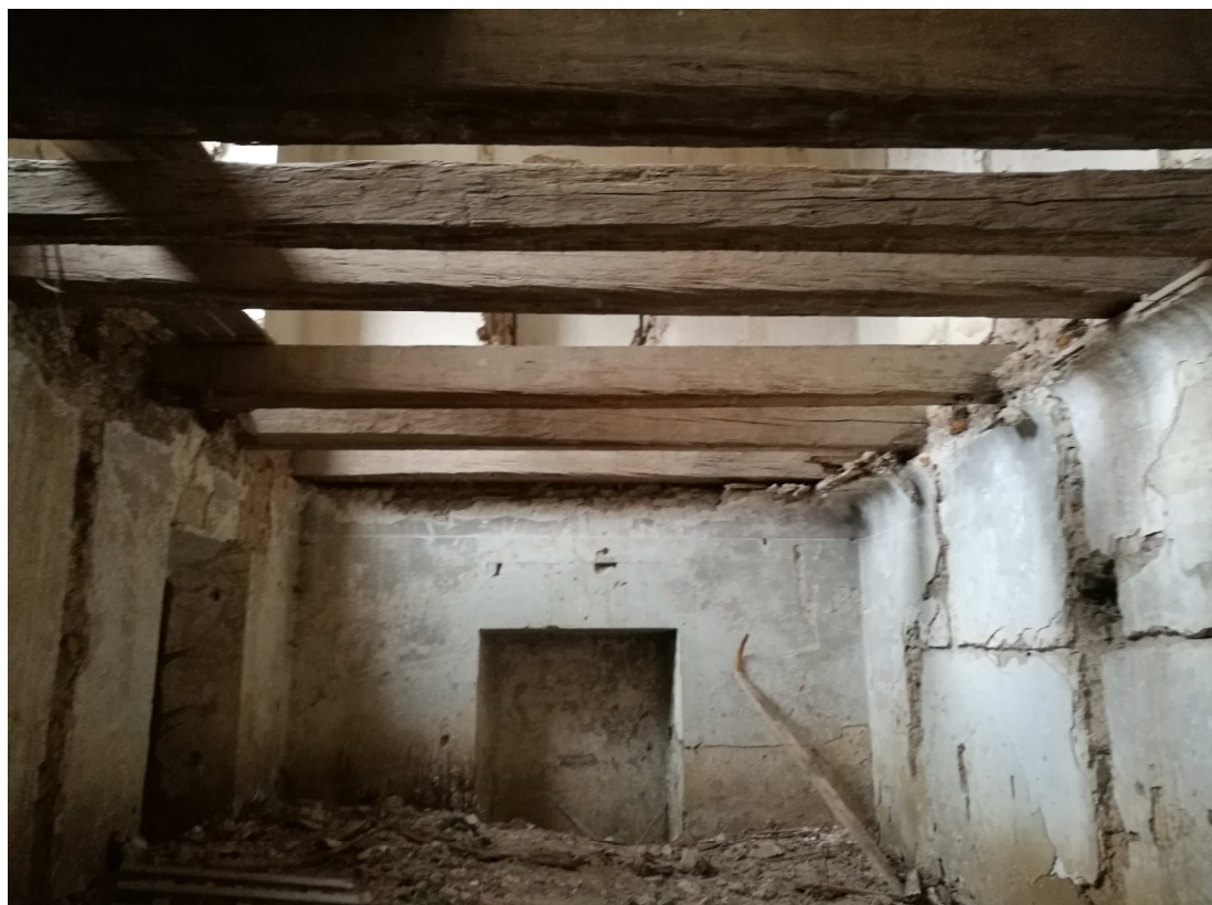
Obr. 13 trámy původního trámového stropu místnosti 104
