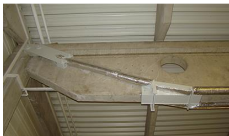
Obrázek 3.22: Zesílení střešního vazníku [17]
