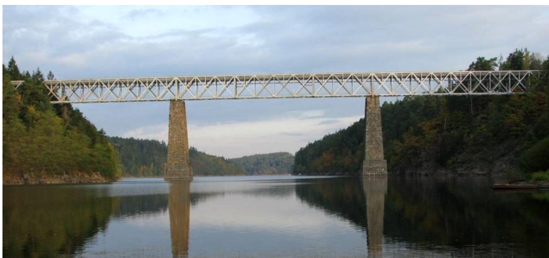
Obr. 18 Červená: Pohled na most Zdroj: [13]
