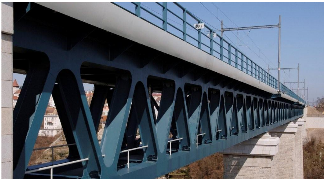
Obr. 22 Znojemský viadukt: Pohled na most Zdroj: [19]
