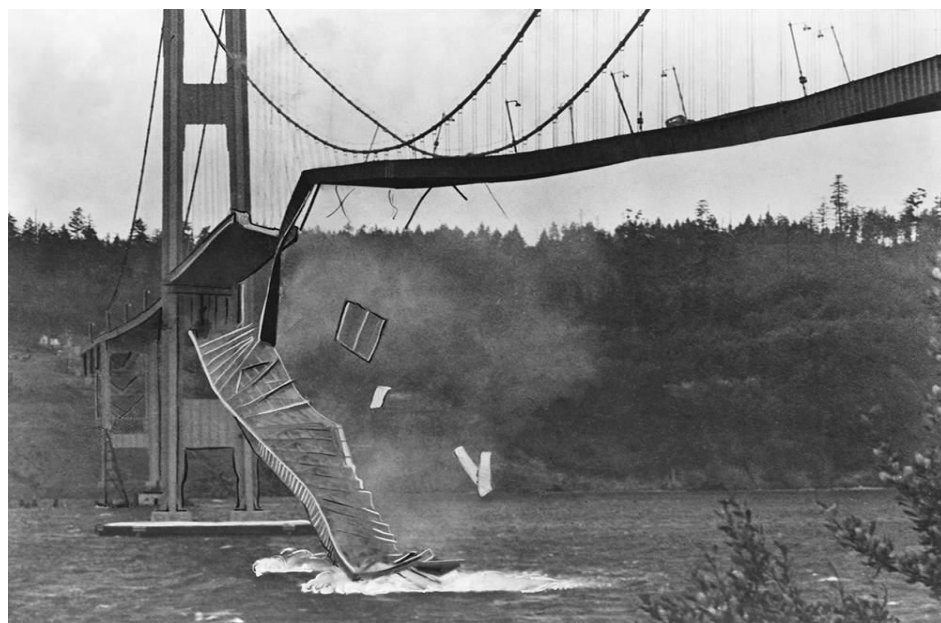
Obr. 6 Zřícení mostu Tacoma Narrows
