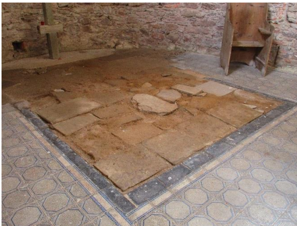
Obr.18,19.: Pohled do prostoru presbytáře. Volné plochy jsou vydlážděny šamotovou dlažbou, ostatní pískovcovými deskami. Vpravo podlaha z litého betonu u hlavního vstupu.
