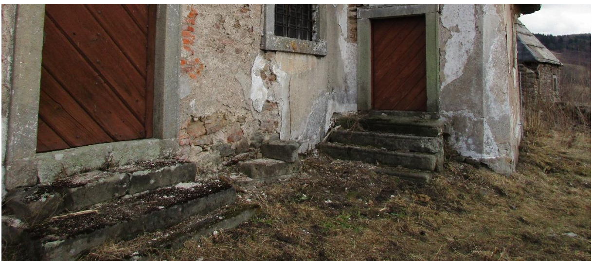
Obr.10.: Vnější schodiště na jižní straně.
