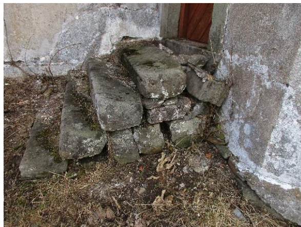
Obr.50a,50b.: Pohled na vnější kamenná schodiště. Vpravo havarijní stav schodiště do sakristie. Za povšimnutí stojí taktěž stopy po vzlínající vlhkosti.
