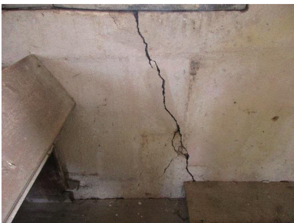
Obr.38a, 38b: Trhlina pod parapetem jednoho z oken v 2.NP.
