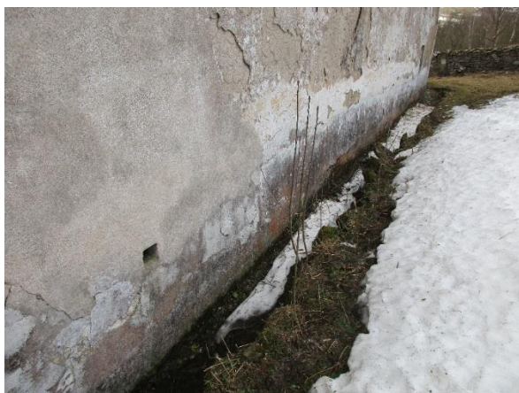
Obr.42,43.: Příkop podél severní stěny. Dobře patrné projevy vlhkosti. V horní části snímku odloupaná svrchní vrstva omítky v důsledku vztlínání vody. Vpravo poškození jižní stěny věže.
