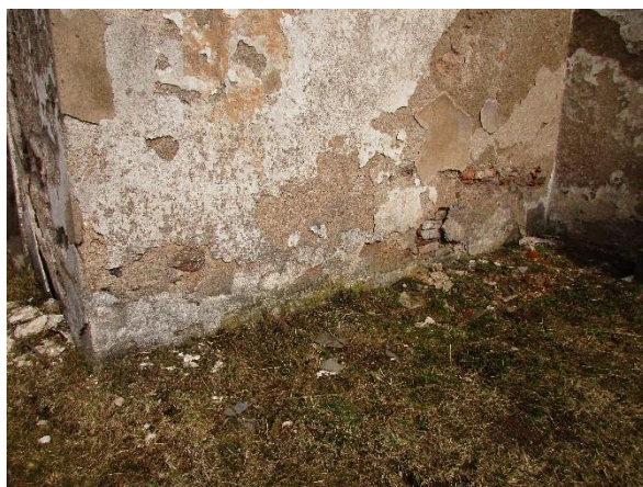
Obr.42,43.: Příkop podél severní stěny. Dobře patrné projevy vlhkosti. V horní části snímku odloupaná svrchní vrstva omítky v důsledku vztlínání vody. Vpravo poškození jižní stěny věže.
