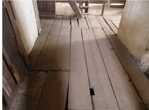
Obr.12.: Podlaha věže v 2.NP.
