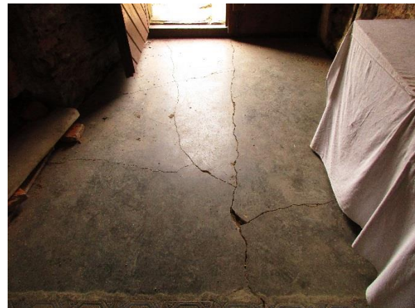
Obr.18,19.: Pohled do prostoru presbytáře. Volné plochy jsou vydlážděny šamotovou dlažbou, ostatní pískovcovými deskami. Vpravo podlaha z litého betonu u hlavního vstupu.
