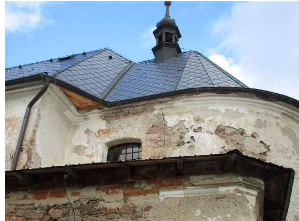
Obr.15,16.: Zastřešení presbytáře, sanktusník a pohled na novodobé dozdění římsy sakristie.
