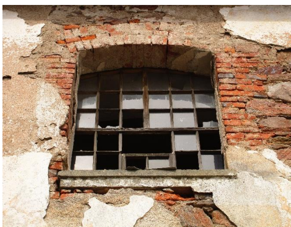
Obr.23.: Okno jižního průčelí.
