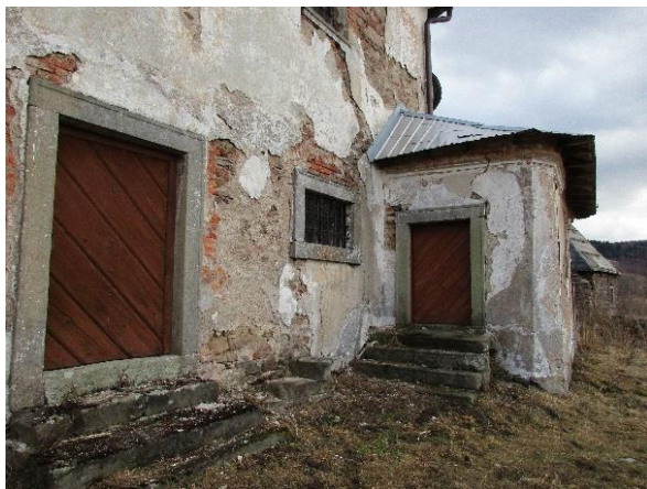
Obr.50a,50b.: Pohled na vnější kamenná schodiště. Vpravo havarijní stav schodiště do sakristie. Za povšimnutí stojí taktěž stopy po vzlínající vlhkosti.
