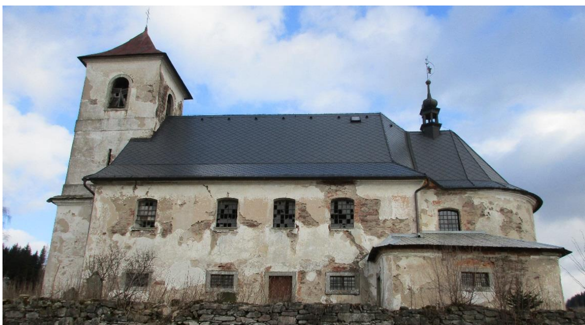
Obr.25.: Jižní průčelí kostela.
