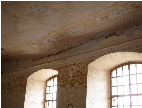
Obr.36: Održení stropu od stěn.
