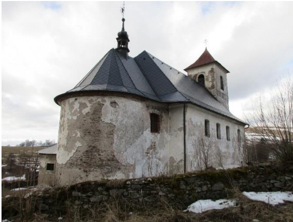
Obr.15,16.: Zastřešení presbytáře, sanktusník a pohled na novodobé dozdění římsy sakristie.
