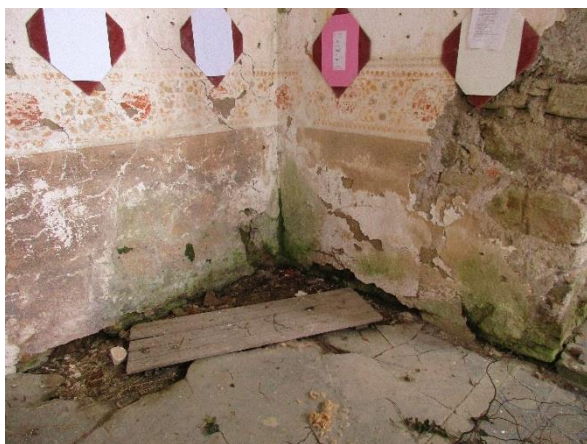
Obr.44,45.: Poškozené omítky důsledkem zvýšené vlhkosti a plesnivěním.
