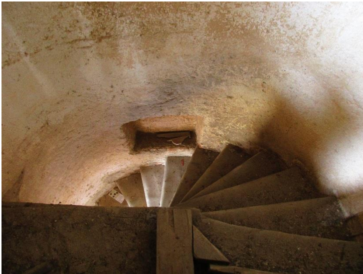
Obr.8.: Točité schodiště mezi 1.NP a 2.NP.
