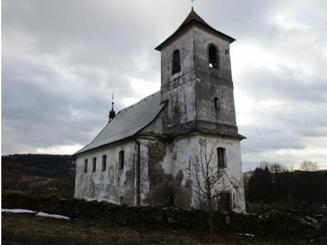
Obr.3.: Pohled ze severozápadu.
