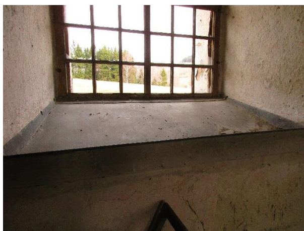
Obr.24.: Oplechování vnitřního parapetu.
