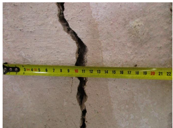
Obr.38a, 38b: Trhlina pod parapetem jednoho z oken v 2.NP.
