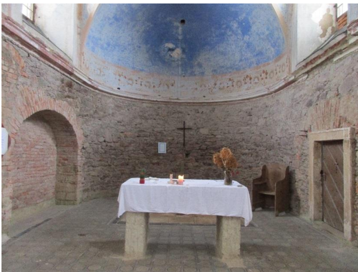
Obr.29,30.: Pohled do presbytáře. Kompletně osekané omítky v celé úrovni 1.NP. Vpravo pohled na zrcadla na stropu lodi.
