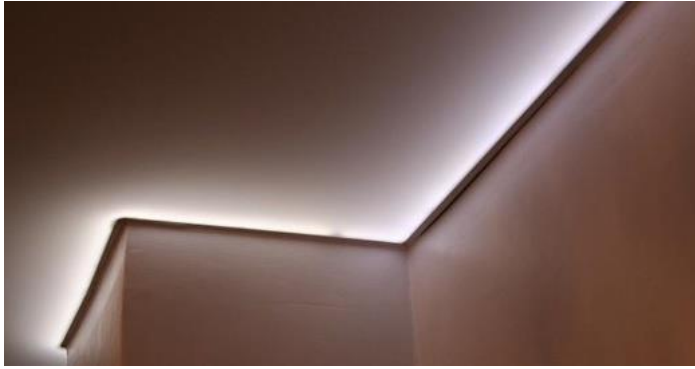
Obr. 15: Napínané podhledy podsvícení stropu 34
