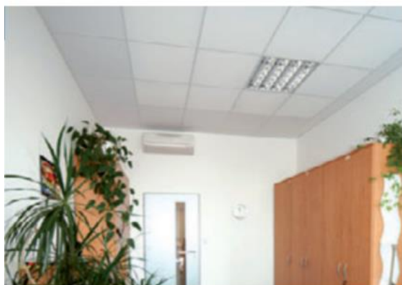
Obr. 10: CASOROC Stropní kazeta v bílém matném provedení s hladkým povrchem bez perforace 24
