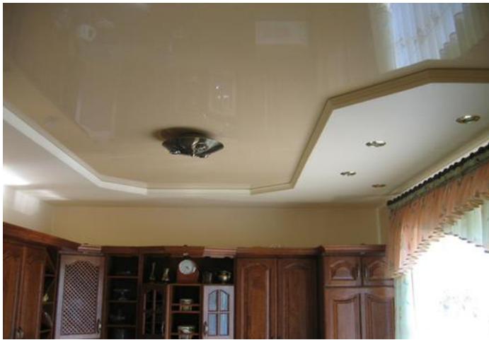
Obr. 16: Strop v kombinaci s pevnou sádkartonovou konstrukcí 35
