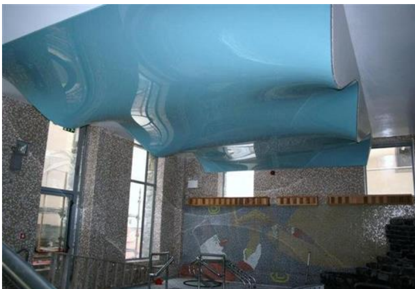
Obr. 18: Tvarovaný napínaný strop - bazén 38
