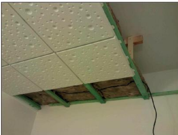
Obr. 13: Stropní kazety Bublinky jemné - montáž 31
