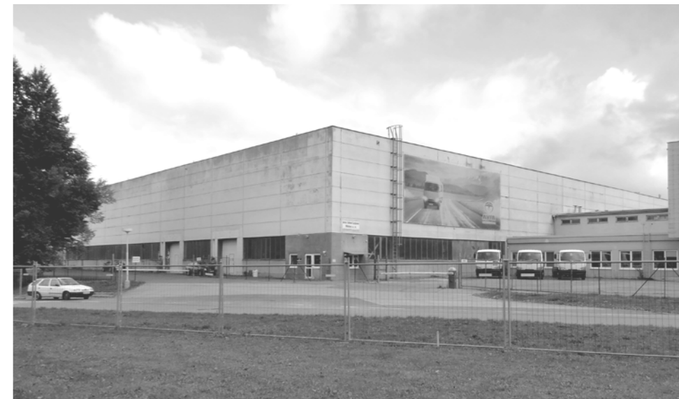
Hala na začátku areálu
