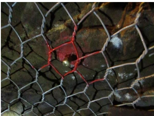
Obr. 7 - Stropní stabilizace bodu č. 503
