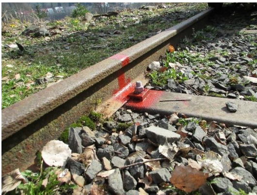
Obr. 6 - Stabilizace bodu č. 500
