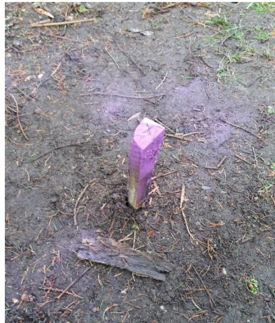
Obr. 22: Stabilizace stanoviště pomocí dřevěného kolíku
