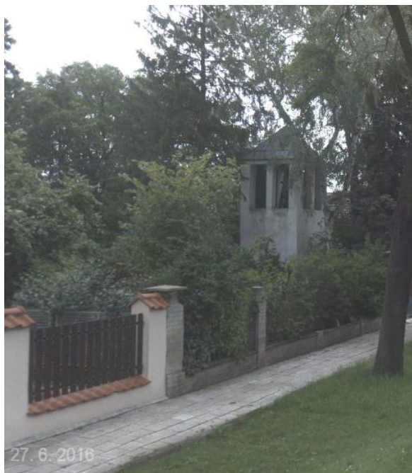
Obr. 3: Původní stav zvoničky [1]
