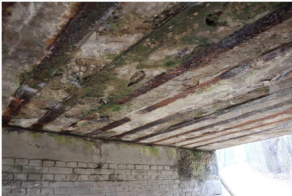
Obrázek 15 – Dolní povrch hlavní nosné konstrukce K01
