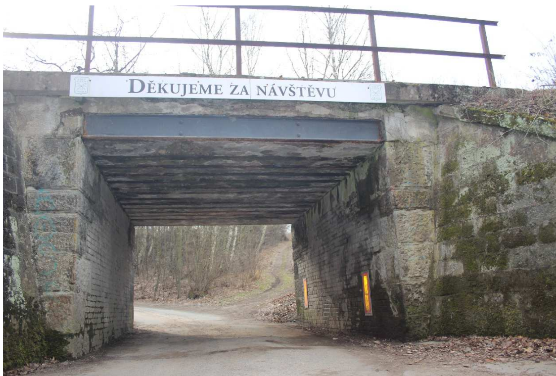
Obrázek 5 - Pohled na konstrukci ze severu
