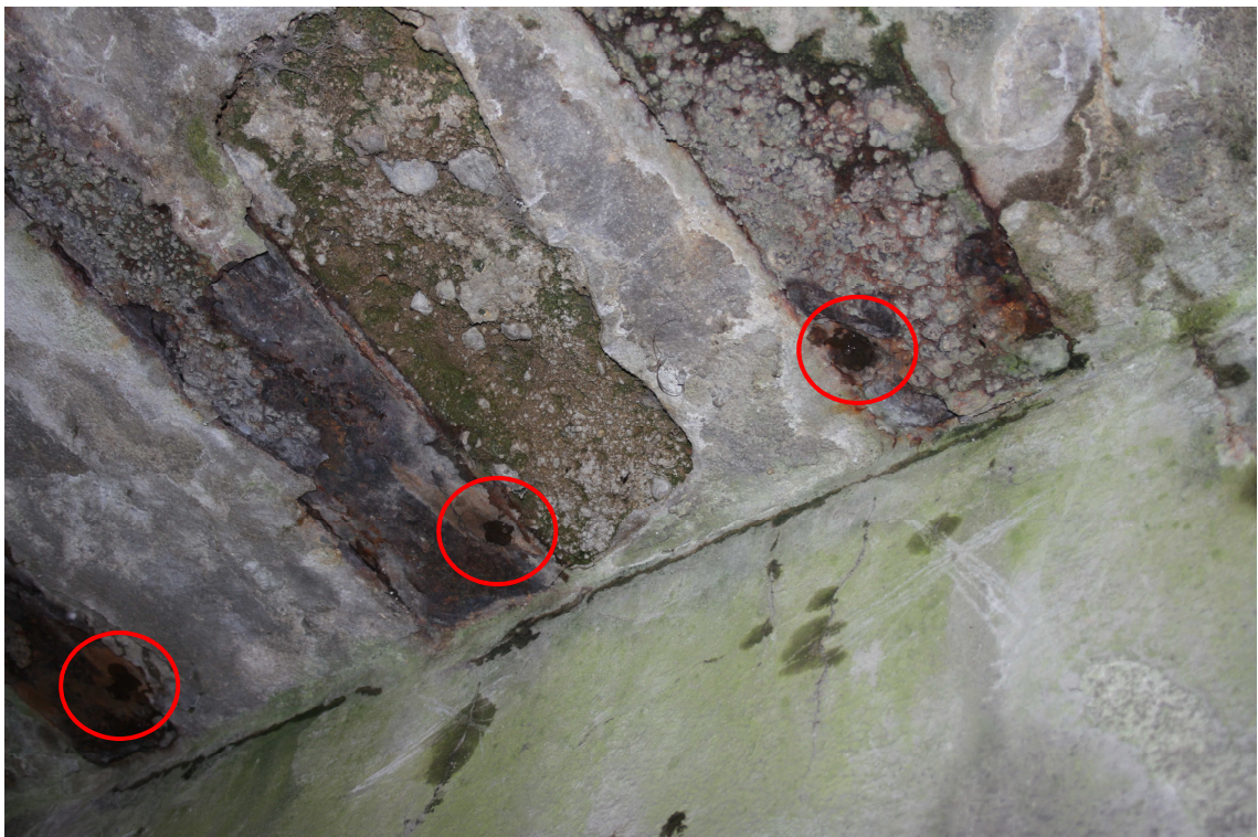
Obrázek 22 - Místa měření tloušťky ocele (vyznačené stopy gelu pro ultrazvukové měření)
