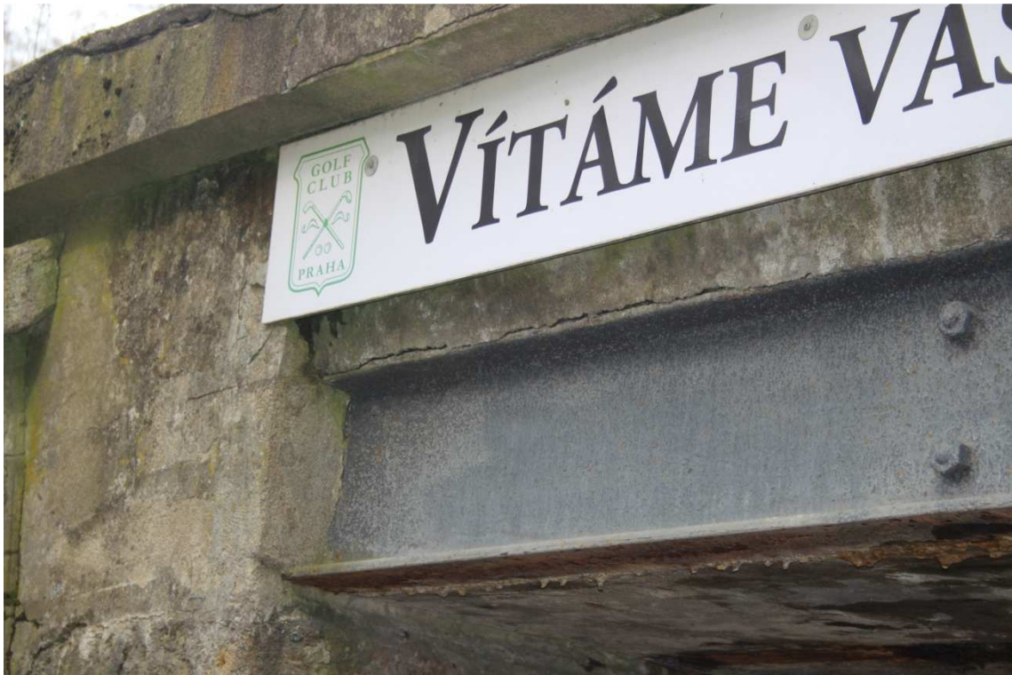
Obrázek 21 - Jižní krajní nosník
