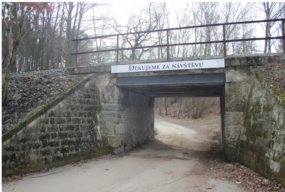
Obrázek 14 – Pohled zprava na křídla a konstrukci
