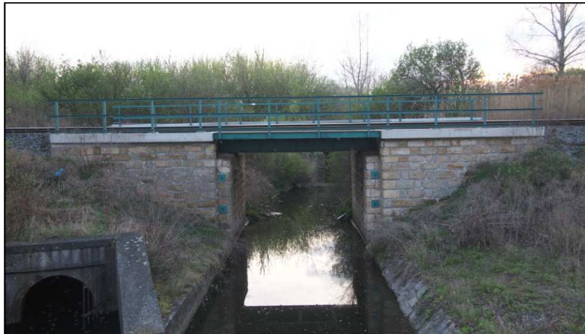
Obrázek 1 - Most přes Červenomlýnský potok
