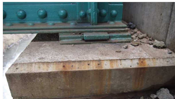
Obrázek 9 - Pevné ložisko na opěře O2
