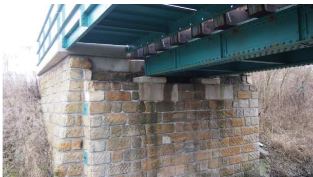
Obrázek 11 - Pohled na opěru O1
