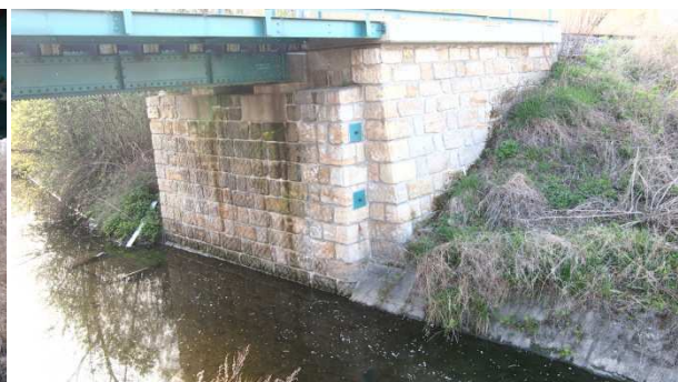
Obrázek 12 - Pohled na opěru O2
