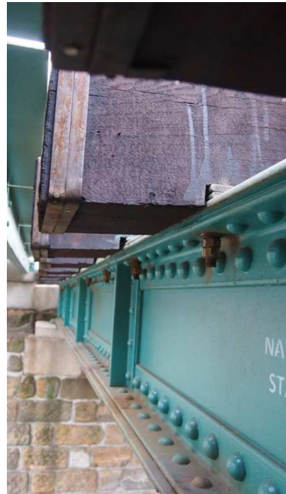
Obrázek 3 - Připevnění mostnic mostnicovými šrouby
