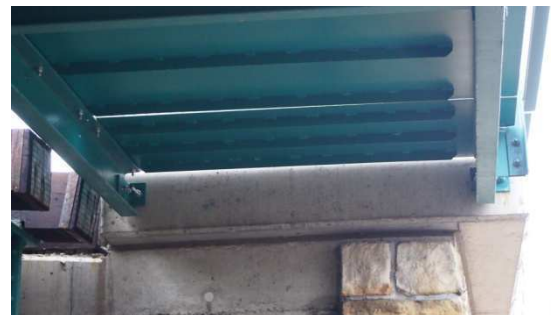
Obrázek 5 - Kotvení podlahových nosníků U200
