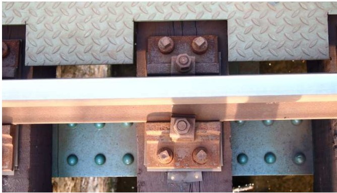
Obrázek 2 - Kolejnice s upevněním typu K
