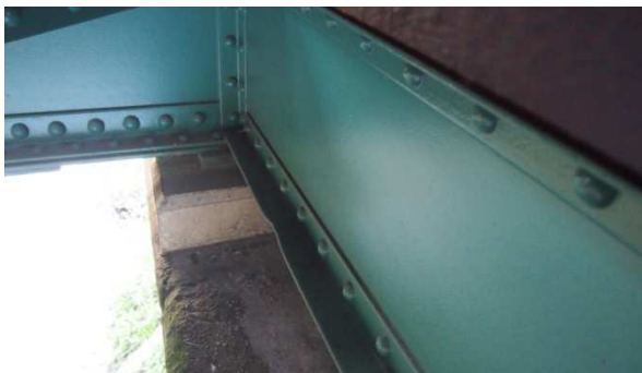
Obrázek 16 - Zvlněná pásnice příčniku
