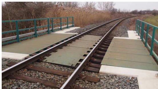
Obrázek 4 - Chodníky se zábradlím
