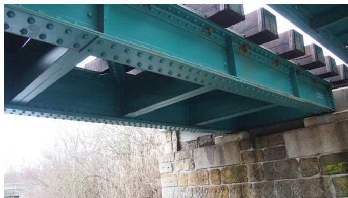
Obrázek 7 - Pohled na nosnou konstrukci zespodu
