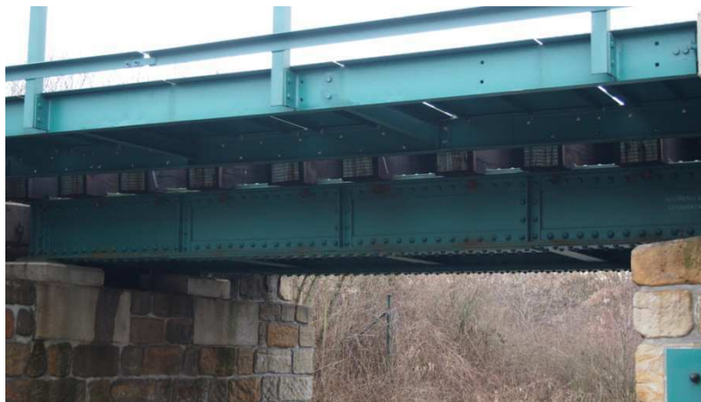
Obrázek 6 - Upevnění zábradlí na podlahové nosníky
