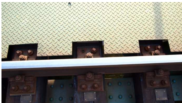
Obrázek 14 - Chybějící vrtule
