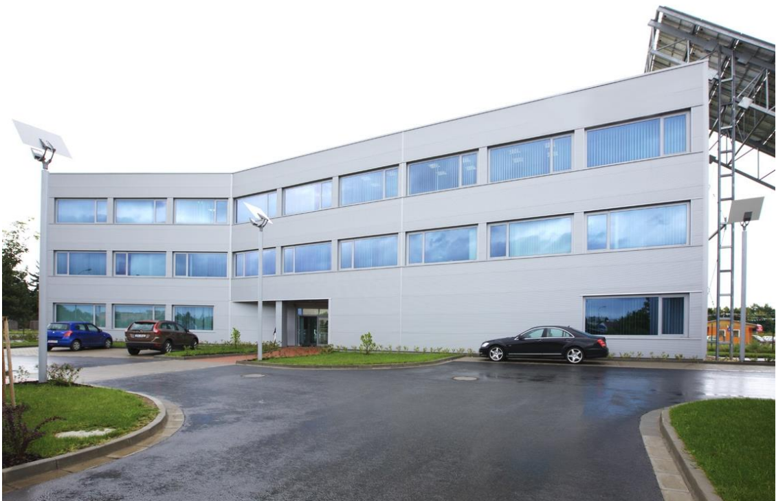
Obr. 3.1 Budova firmy M-tech, s.r.o
