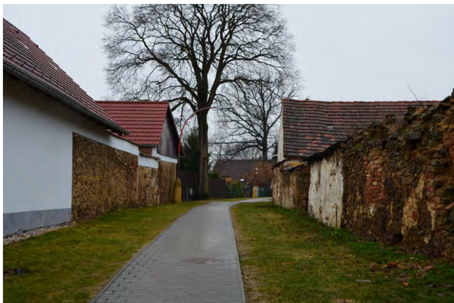
Obrázek 1.22: 12: Neudržovaná stavba, vlastní fotografie (březen 2017)
