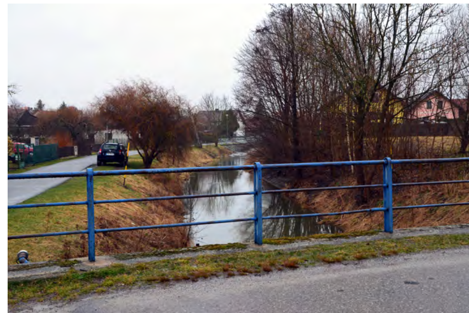
Obrázek 1.20: Problém 10: Koryto toku Řečice, vlastní fotografie (březen 2017)
