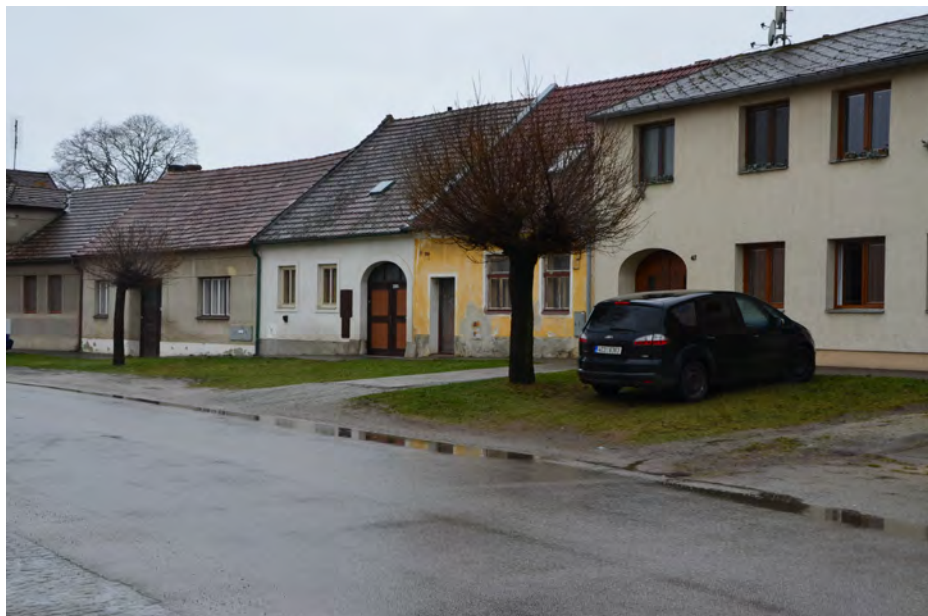
Obrázek 1.26: 16: Neudržovaná stavba, vlastní fotografie (březen 2017)
