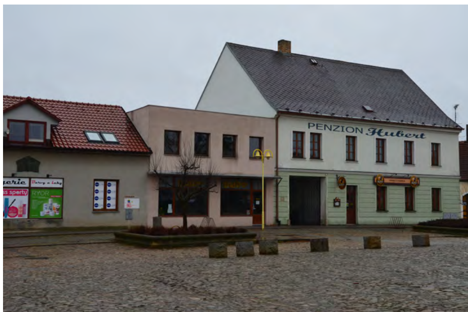
Obrázek 1.23: 13: Nevhodná koncepce stavby, vlastní fotografie (březen 2017)
