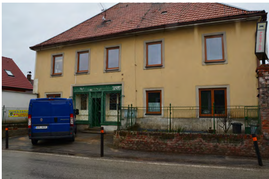
Obrázek 1.27: 17: Neudržovaná stavba, vlastní fotografie (březen 2017)
