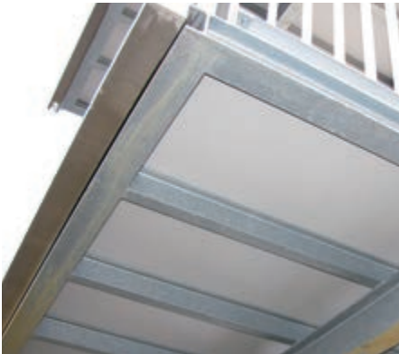
SPODNÍ KONSTRUKCE / NOSNÍKY
