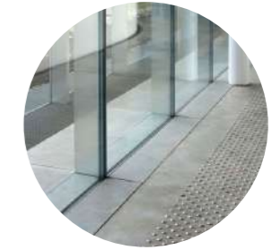
DETAIL - ukončení strukturálního zasklení
