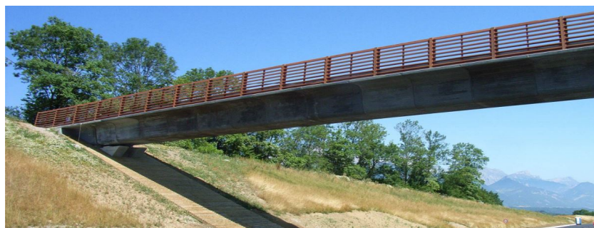
Obr. 8 Pohled na Pont de la Chabotte
