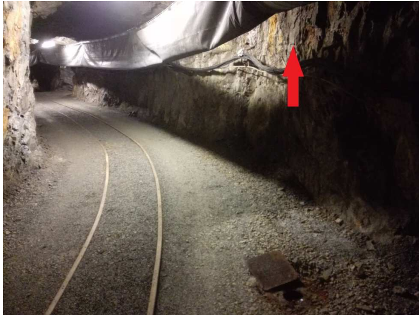
Obr. 8 – umístění bodu 7908 při pohledu do postranní chodby
