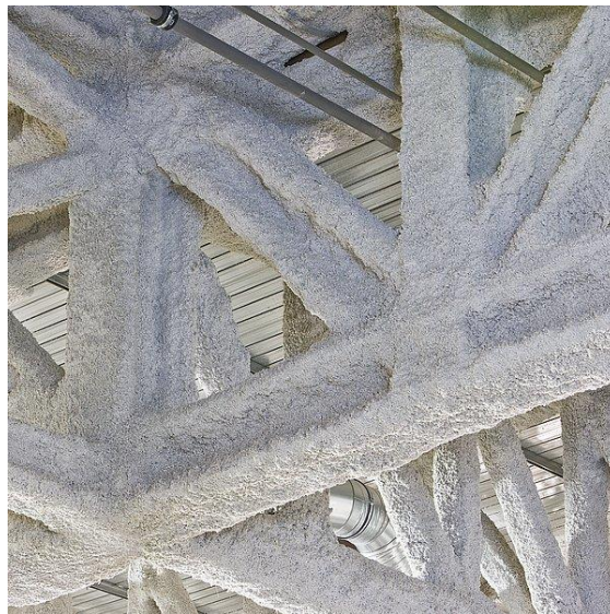
obr. 1 Nástřik na ocelovém vazníku [4]
