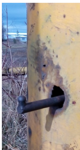
Obr. 3.4 Nivelační čep v dolní části pilíře
