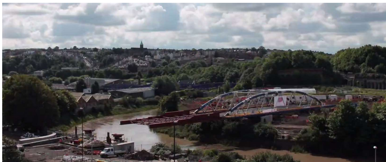
Obr. 10 Výsun mostu přes řeku Avon [9]
