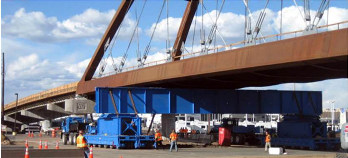
Obr. 8 Konstrukce pro podepření mostu při přepravě [5]
