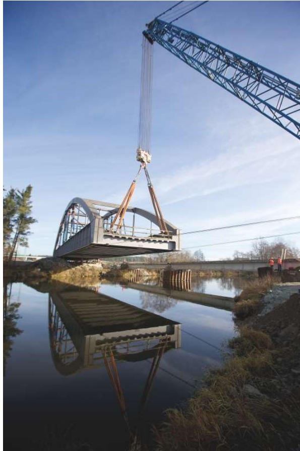
Obr. 13 Výsun mostu s podporou jeřábu – Veselí nad Lužnicí [12]
