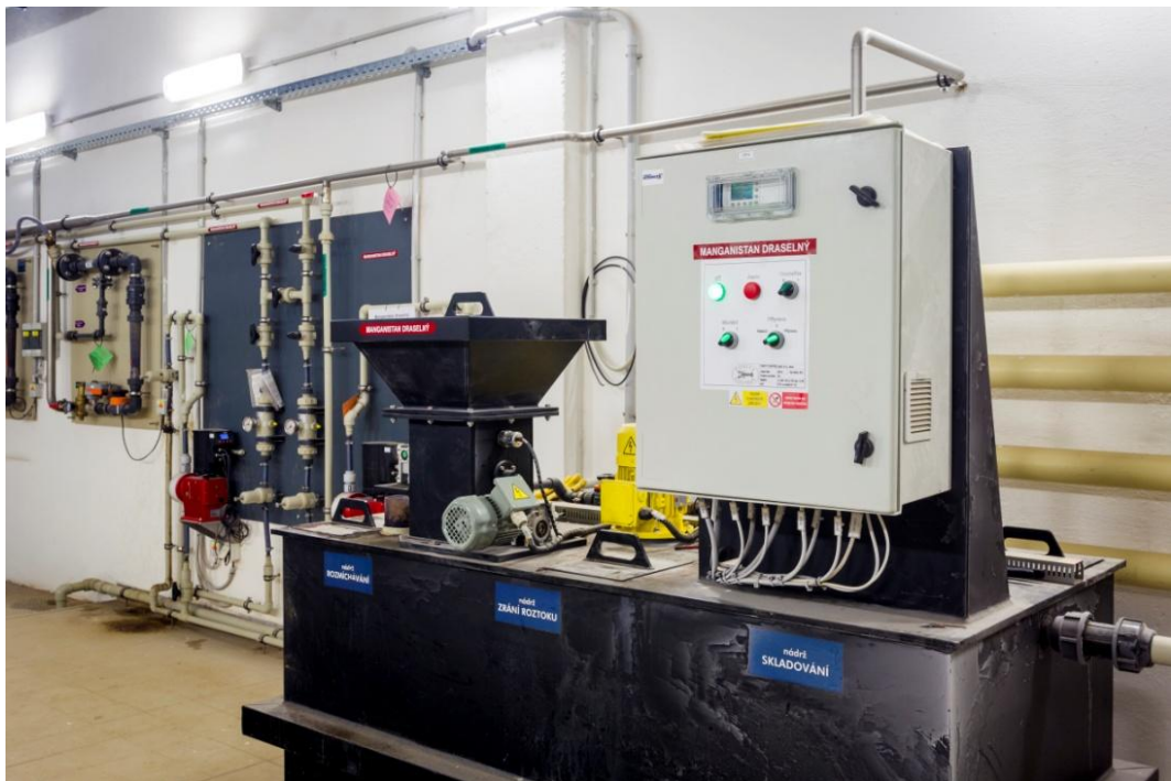
Obr. 24 Stanice na dávkování manganistanu draselného [foto poskytnuté úpravnou]
