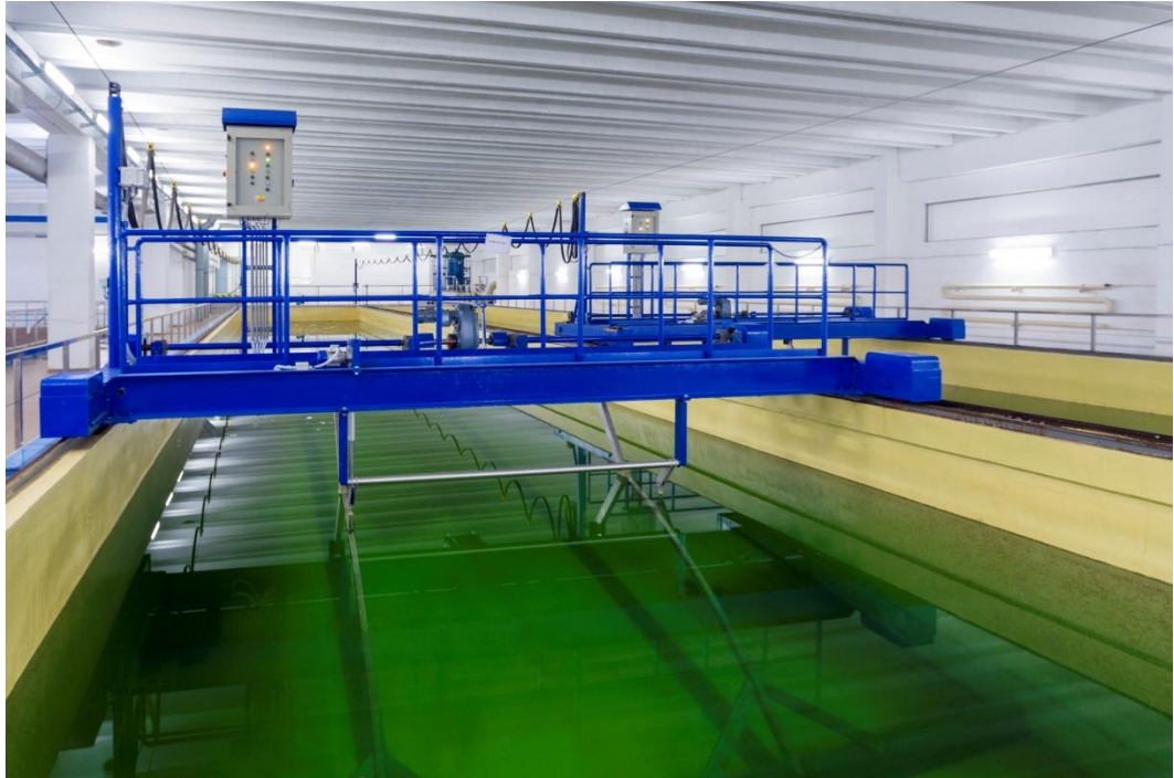
Obr. 23 Shrabování sedimentační nádrže [foto poskytnuté úpravnou]
