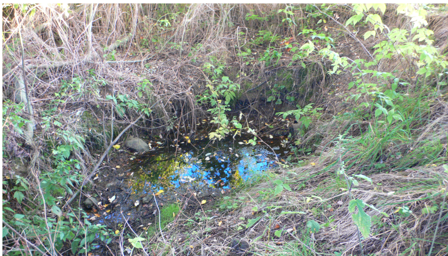
obr. 3.10 Vyústění odpadního potrubí sousední MVN
