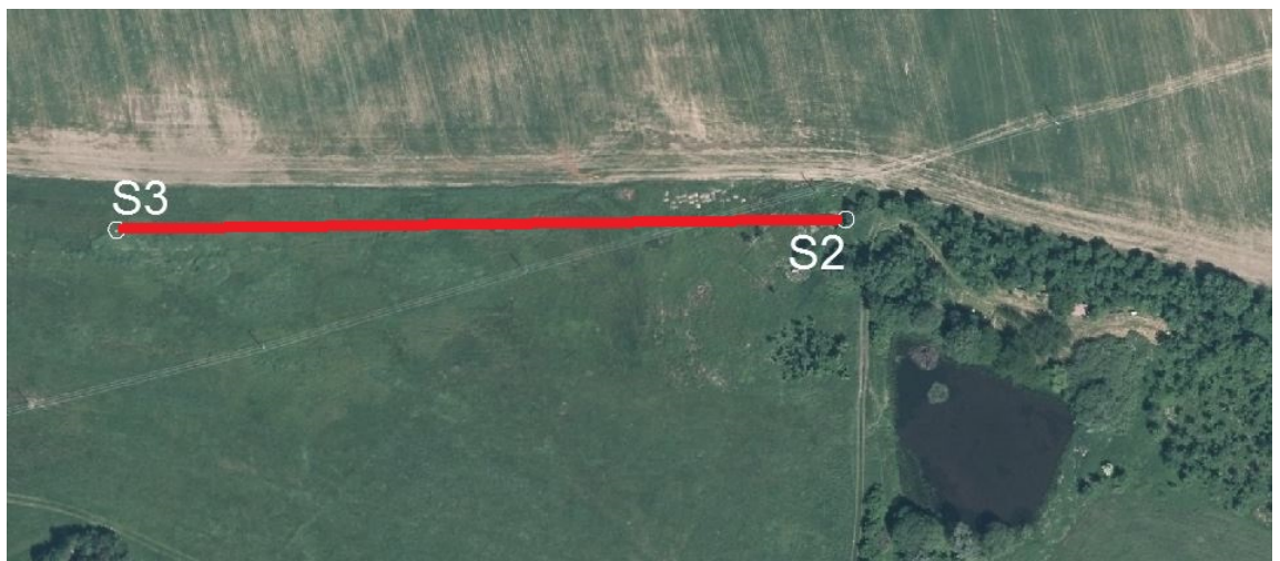
obr. 3.7 Úsek s předpokládanou poruchou drenáže (podklad: ortofotomapa)
