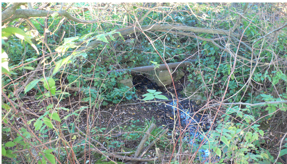
obr. 3.11 Nátok do zatrubněného úseku pod řešeným pozemkem
