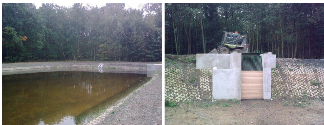
Obr. 6 – Dočišťovací nádrže při, resp. po rekonstrukci – vlevo první nádrž, vpravo třetí nádrž [6]
