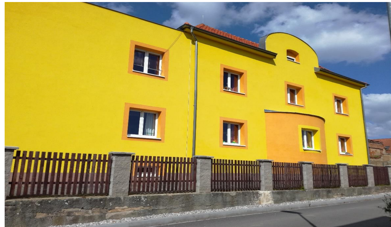
Obr. 22: Mateřská škola. Zdroj: vlastní fotografie
