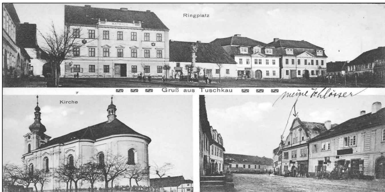
Obr. 9: Pohled na historické budovy města z roku 1918. Zdroj: oficiální stránky Města Touškov
