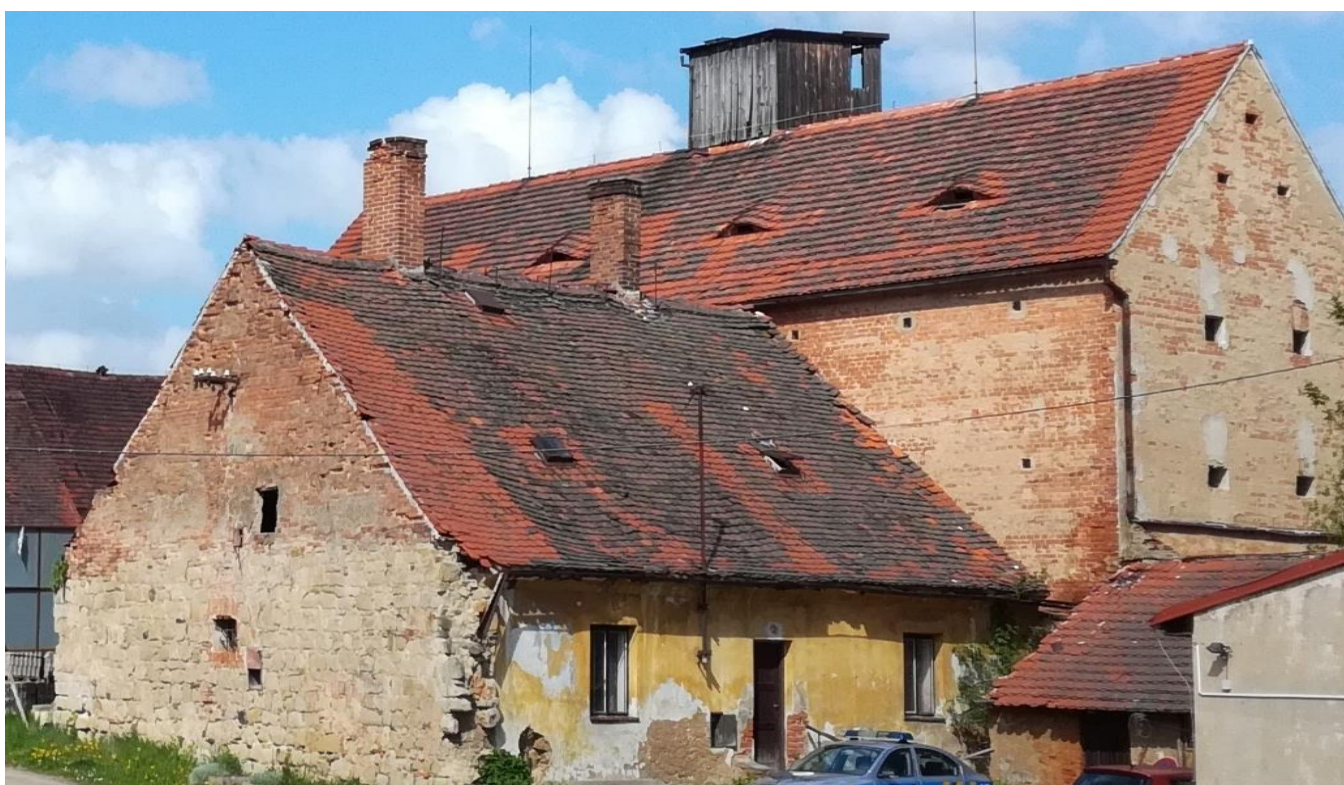
Obr. 17: Historický dům (bývalá šatlava). Zdroj: vlastní fotografie
