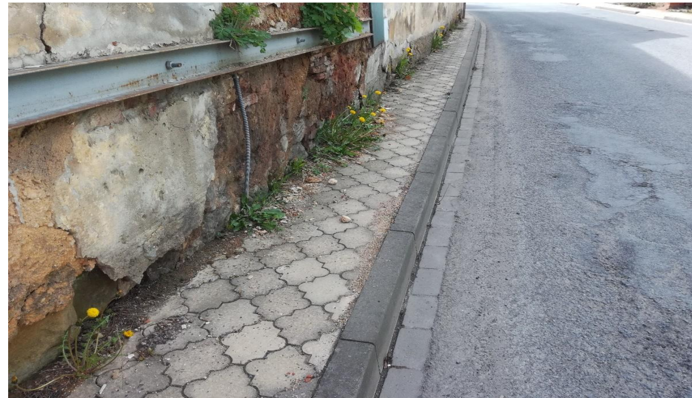
Obr. 30: Zarůstající chodník a nedodržení minimální průchozí šířky 900 mm. Zdroj: vlastní fotografie
