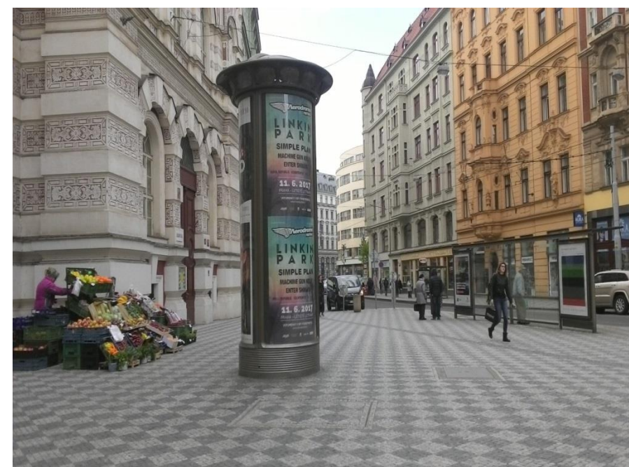
Obrázek 25: Větrací Sloup JCDecaux kolektoru Vodičkova [vlastní zdroj]
