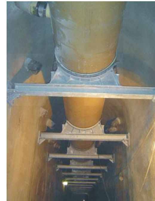
Obrázek 20: Pohled do kolektoru v Ostravě [22]
