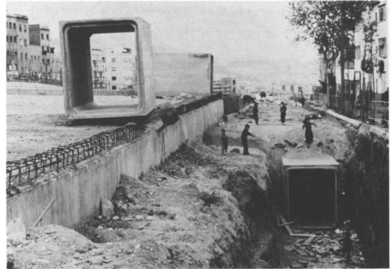
Obrázek 6: Výstavba kolektorů v Barceloně [13].
