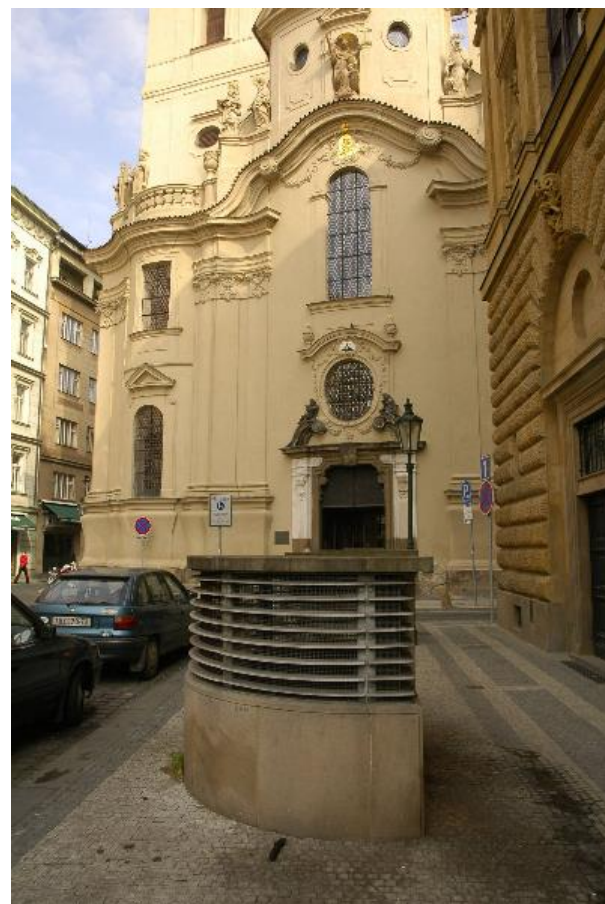
Obrázek 30: Výdech z kolektorové šachty v ulici Havelská [31]
