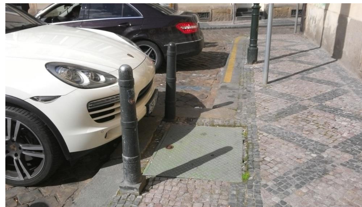
Obrázek 31: Těžký únikový poklop [vlastní zdroj]
