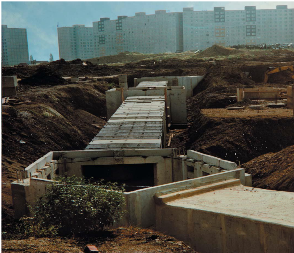
Obrázek 13: Ukázka hloubeného sídlištního kolektoru [4]
