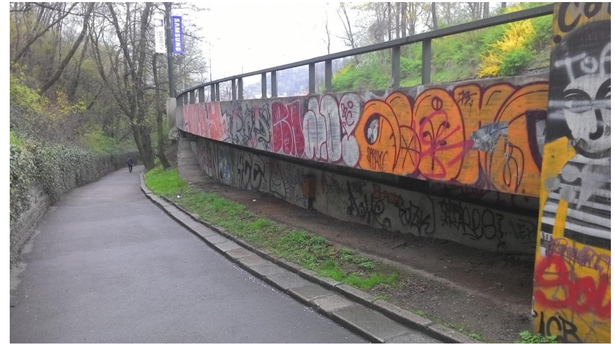
Obrázek 12: Pohled na mostní konstrukci (stěna kolektoru) [vlastní zdroj]
