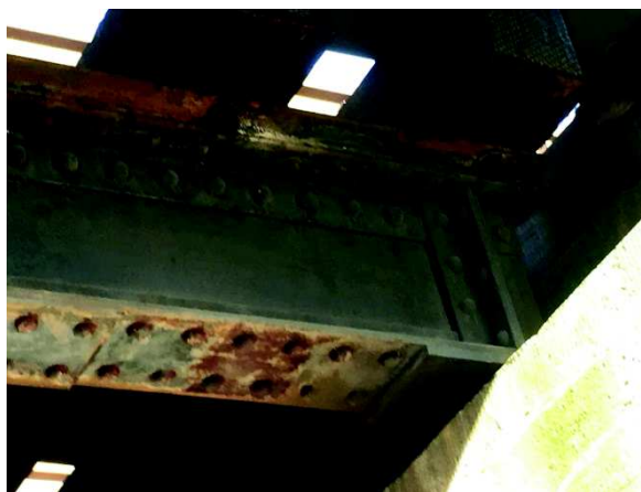
Obr. 2.5: Hlavní nosník (pravý, opěra O 02)
