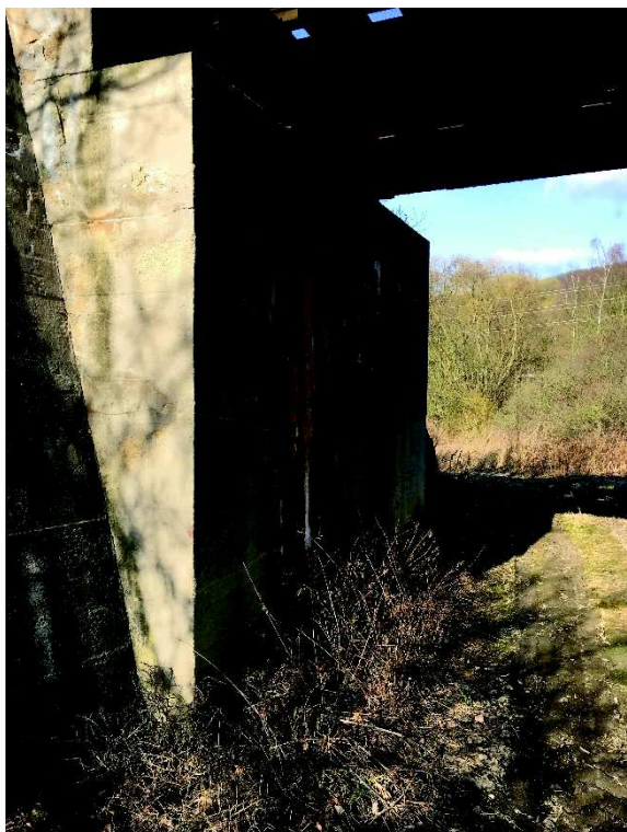
Obr. 2.9 Pohled na opěru O 01
