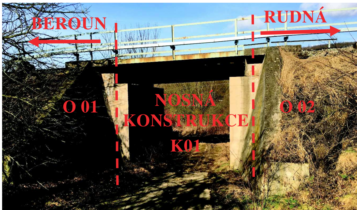
Obr. 2.1: Pohled na most zprava
