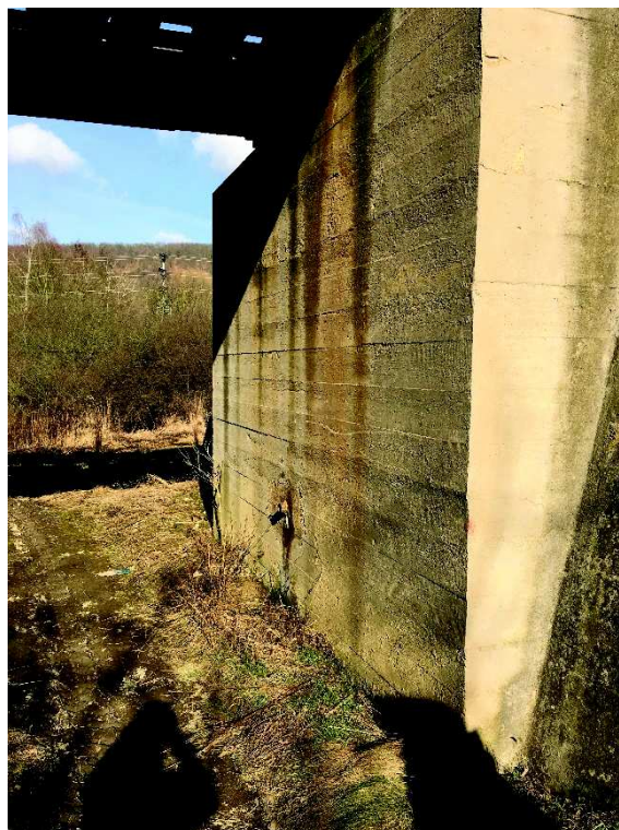
Obr. 2.8: Pohled na opěru O 02
