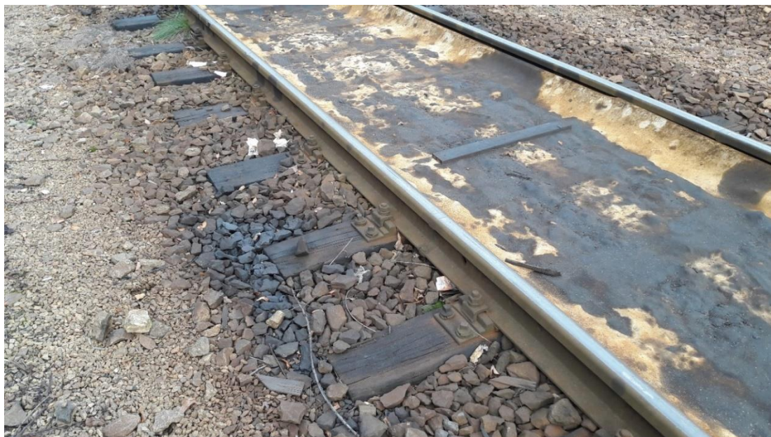
Obrázek 3 Znečištění bočními úkapy, Jihlava 15. 11. 2016
