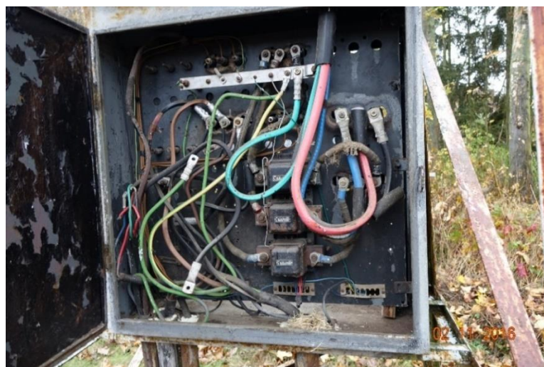
Obrázek 14: Současný stav - propojení vodičů
