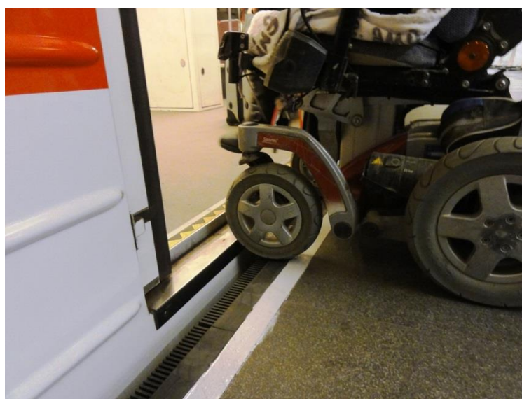
Obrázek č. 5: Pryžový hřebenový profil PGF ve stanici metra Anděl (foto Rampa 2015)
