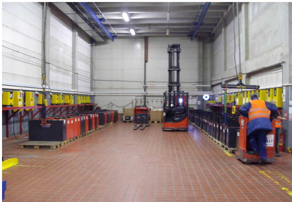
Obrázek 10 – Pravá část baterkárny (Zdroj: autor)
