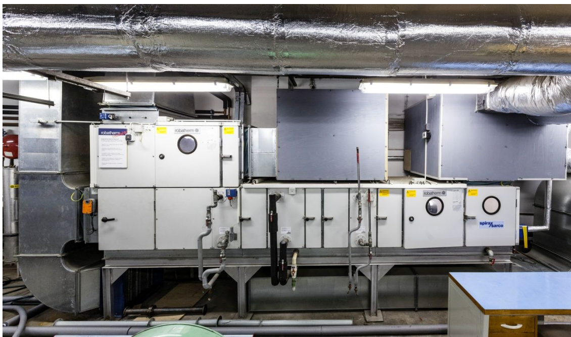
Obr. 6 – Klimatizační jednotka Robatherm [12]
