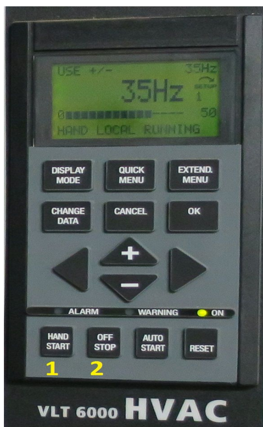
Obr. 8 – Ovládací panel frekvenčního měniče
