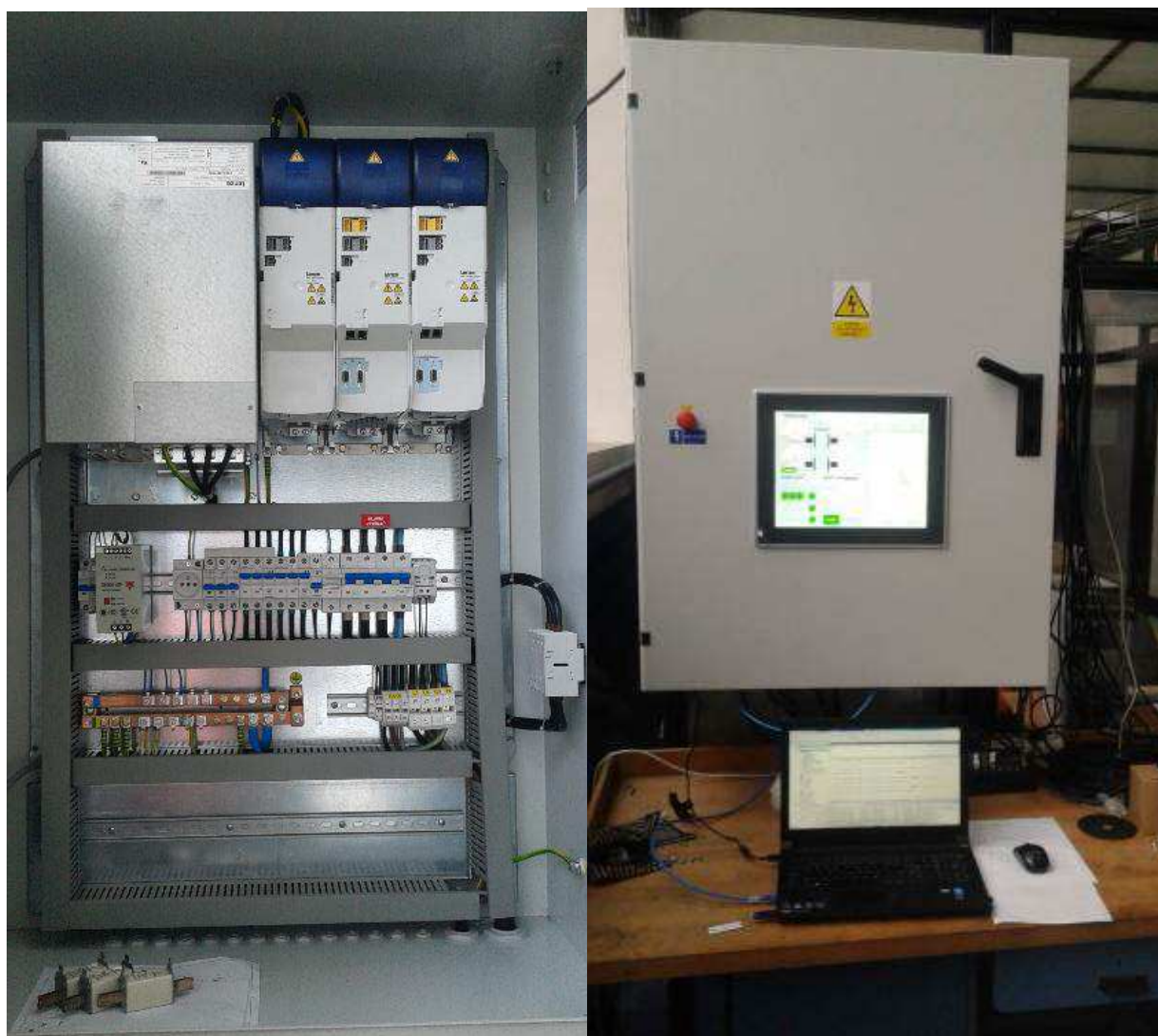
Obr. [11.] Fyzická podoba realizovaného rozvaděče
