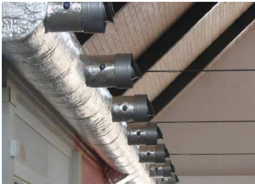
Obrázek 2a – Zařízení pro distribuci tepla a chladu v hypermarketu [1]
