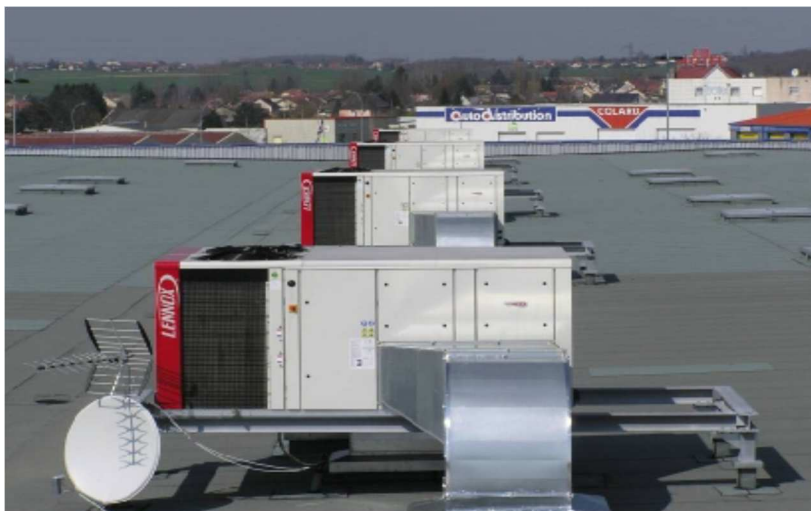
Obrázek 4 - Umístění ROOF-TOPU na střeše hypermarketu [1]
