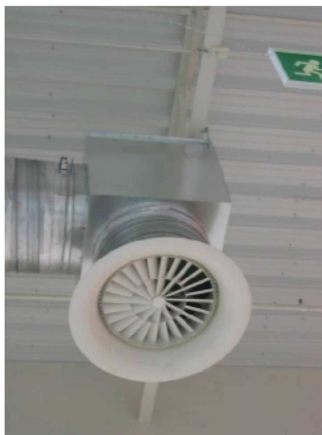
Obrázek 2b – Zařízení pro distribuci tepla a chladu v hypermarketu [1]
