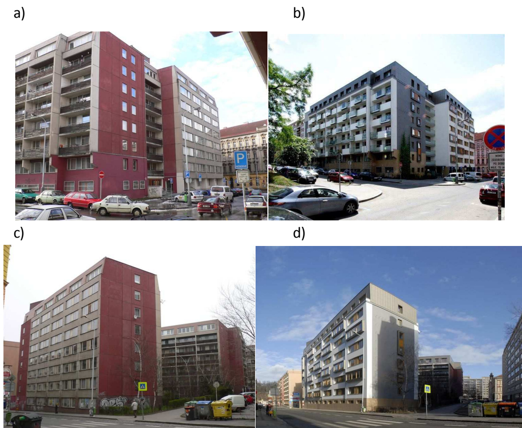
Obr.14 Dům s pečovatelskou službou a) a c) stav před rekonstrukcí b) a d) stav po rekonstrukci, převzato z [11]
