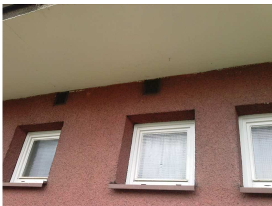
Obr.19 a) nasávací otvory vodorovné šachty b) vyústění šachty na střechě
