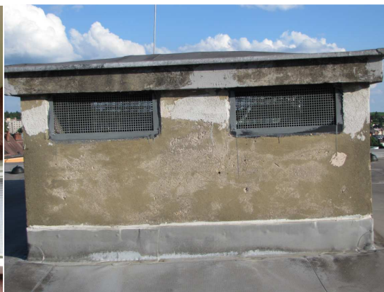
Obr.19 a) nasávací otvory vodorovné šachty b) vyústění šachty na střechě
