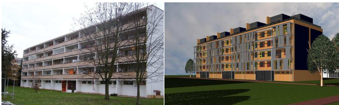
Obr.12 Panelový dům a) před rekonstrukcí b) po rekonstrukci, převzato z [7]
