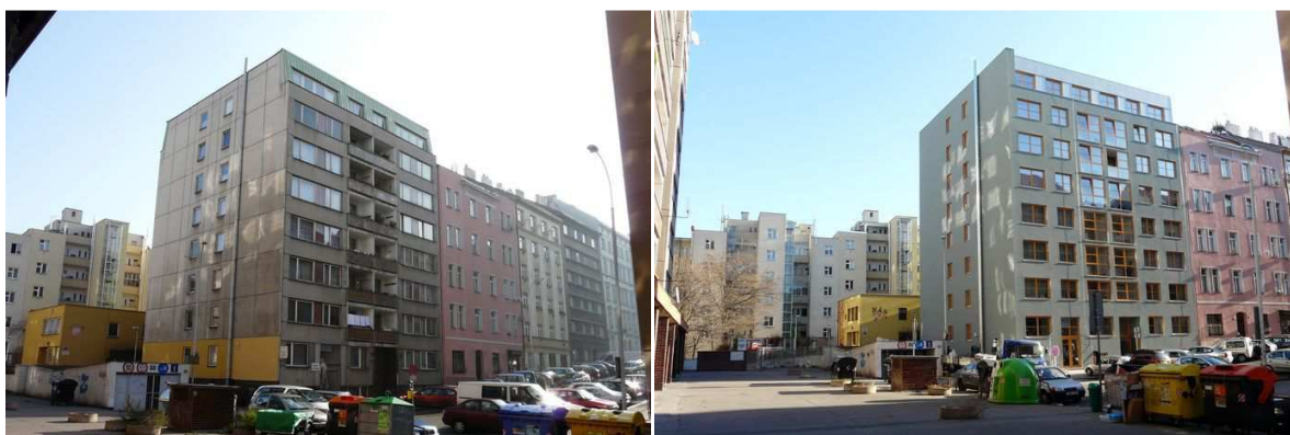
Obr.13 Panelový dům a) před rekonstrukcí b) po rekonstrukci, převzato z [9]
