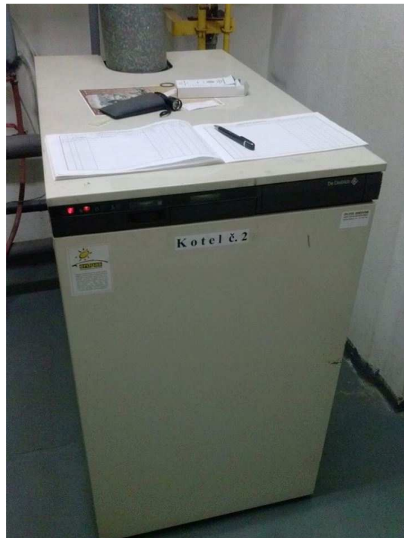
Obr.20 Kotle pro vytápění objektu
