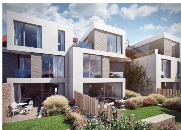
Obr.č.15: Pohled 1 nemovitost č.4
