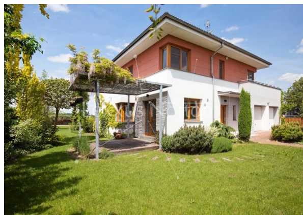
Obr.č.17: Pohled 1 nemovitost č.5
