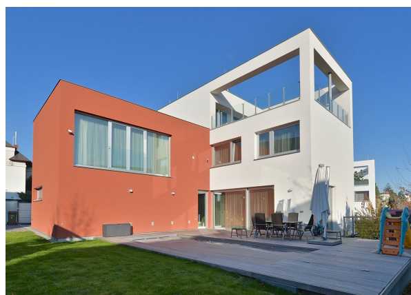
Obr.č.11: Pohled 1 nemovitost č.2
