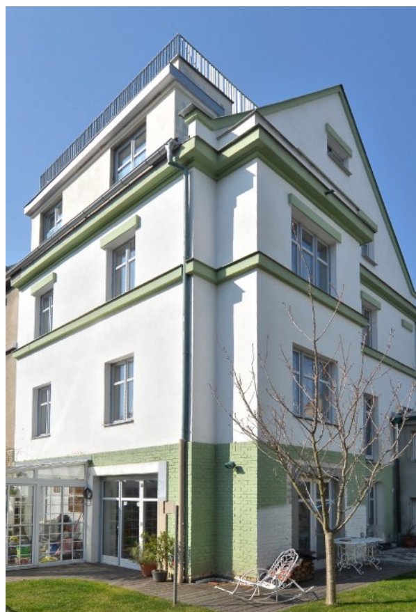
Obr.č.19: Pohled 1 nemovitost č.6
