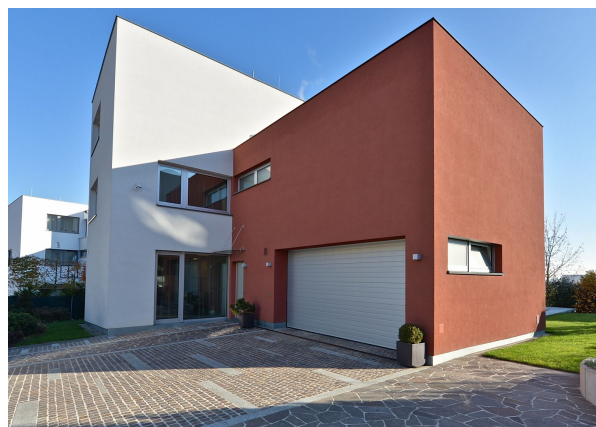
Obr.č.12: Pohled 2 nemovitost č.2
