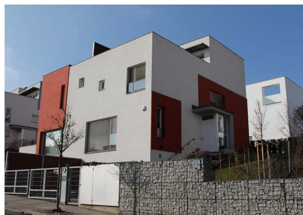
Obr.č.9: Pohled 1 nemovitost č.1
