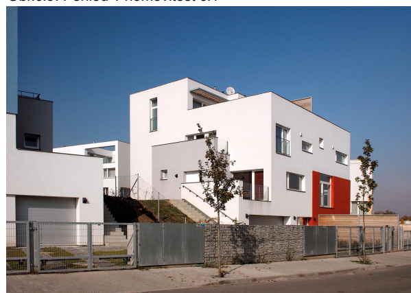
Obr.č.10: Pohled 2 nemovitost č.1
