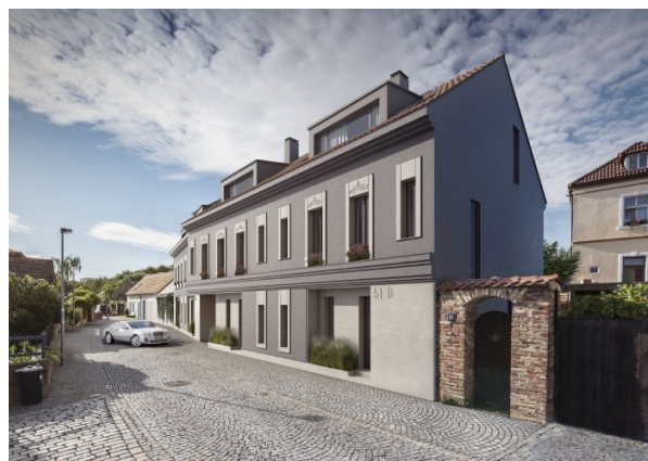
Obr.č.16: Pohled 2 nemovitost č.4
