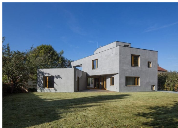
Obr.č.13: Pohled 1 nemovitost č.3
