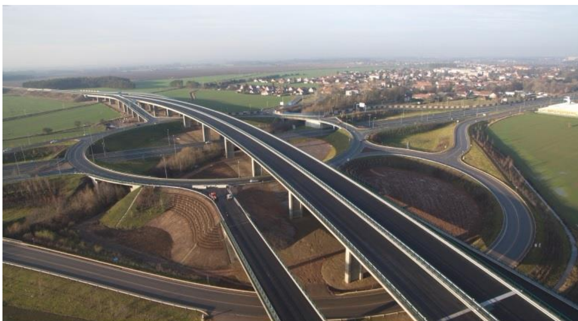
Obrázek 1 - Celkový pohled na estakádu na silnici R35
