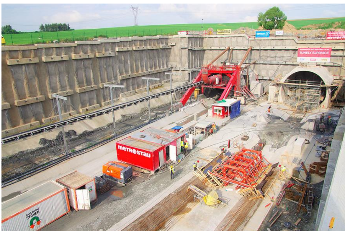
Obrázek 13 - Stavba tunely Ejpvovice realizovaná sdružením společností Metrostav a.s. a Subterra a.s.
