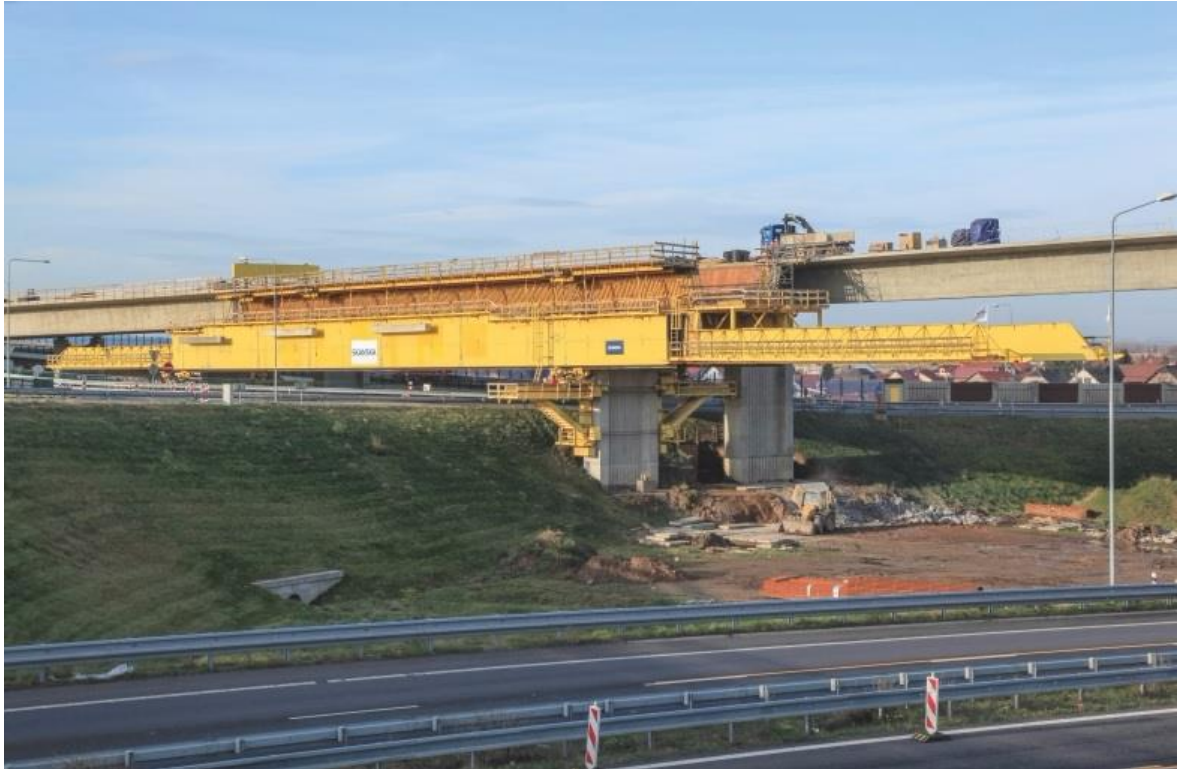
Obrázek 2 - Posuvná skruž Skanska
