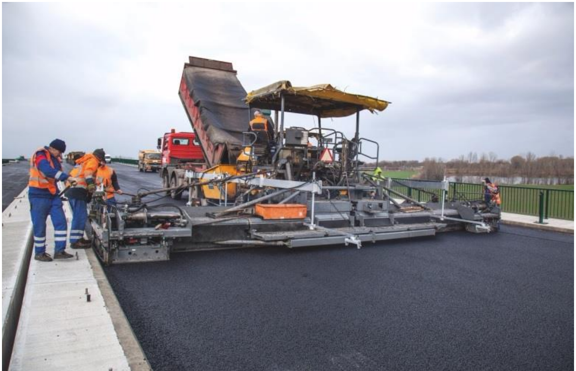
Obrázek 3 - Pokládka asfaltových vrstev
