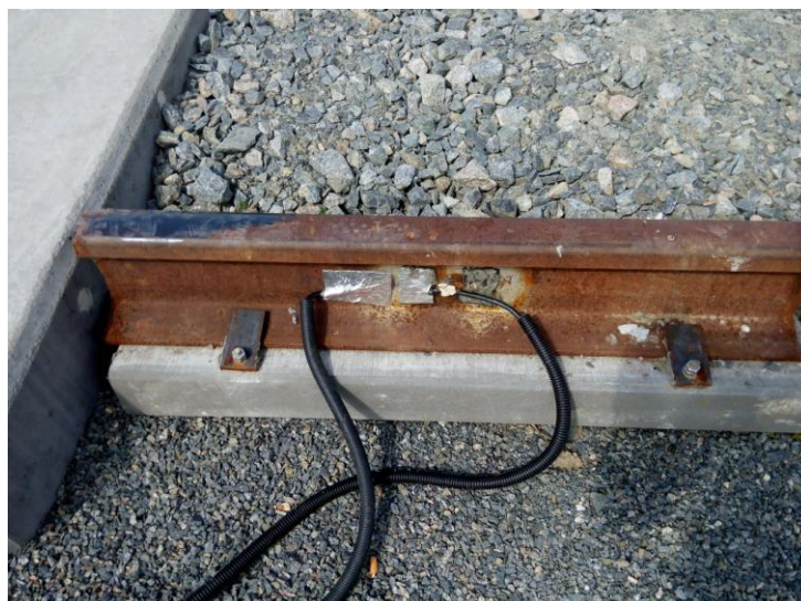
Obr. 128 Kompenzační kolejnice bodu TK21
