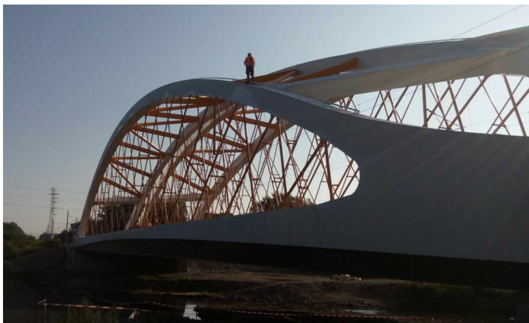
Obr. 34 Pohled na levou konstrukci mostu směrem od vídeňské opěry
