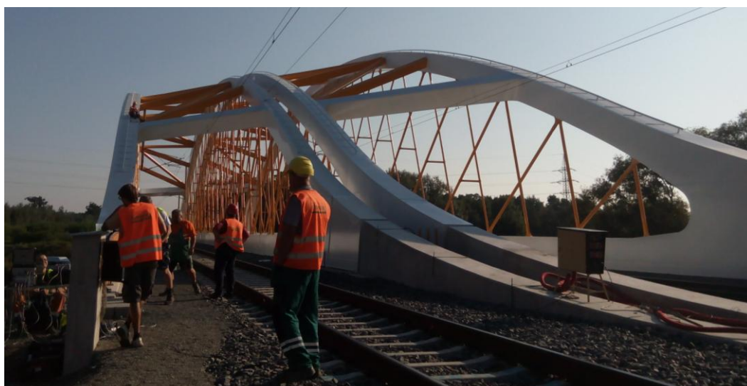
Obr. 35 Pohled od trati na portál nad vídeňskou opěrou
