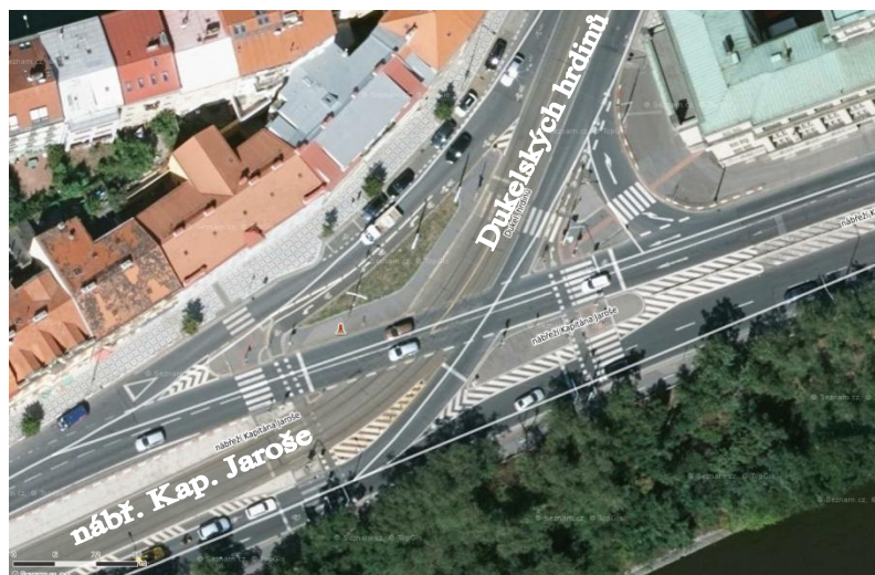
Obr. 55 Pohled na křižovatku nábř. Kap. Jaroše (5)
