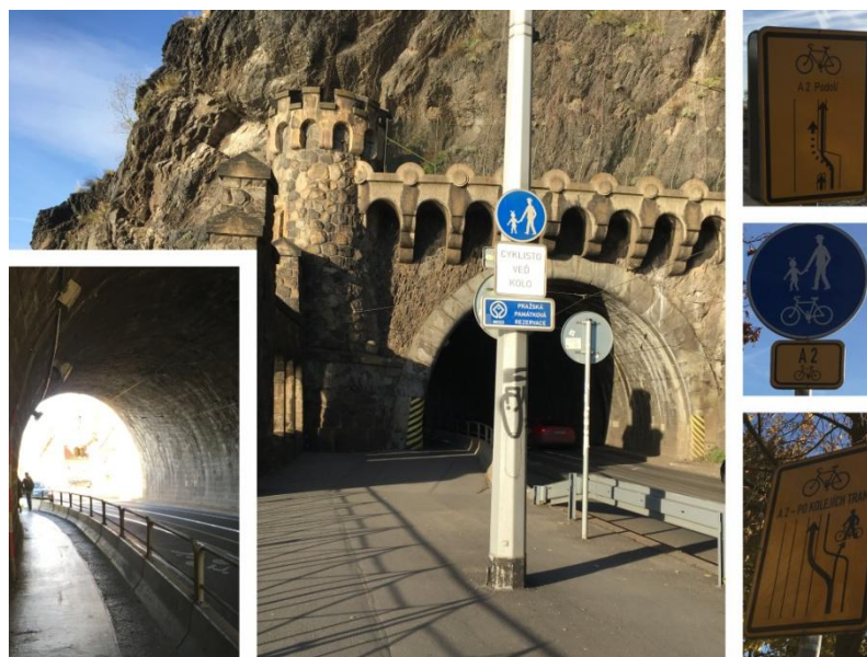
Obr. 62 Fotografie od Vyšehradského tunelu s dopravními značkami pro cyklisty
