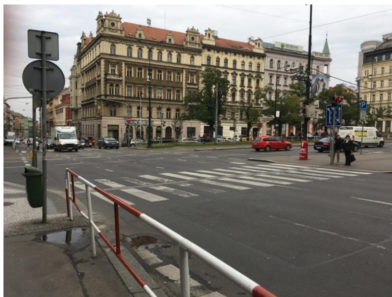
Obr. 12 Pohled na přechod v ulici Sokolská
