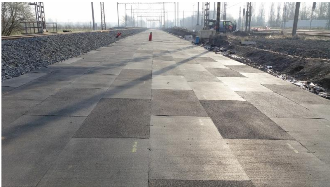
Obrázek 1 Položené antivibrační rohože (u žst. Praha – Běchovice) [4]
