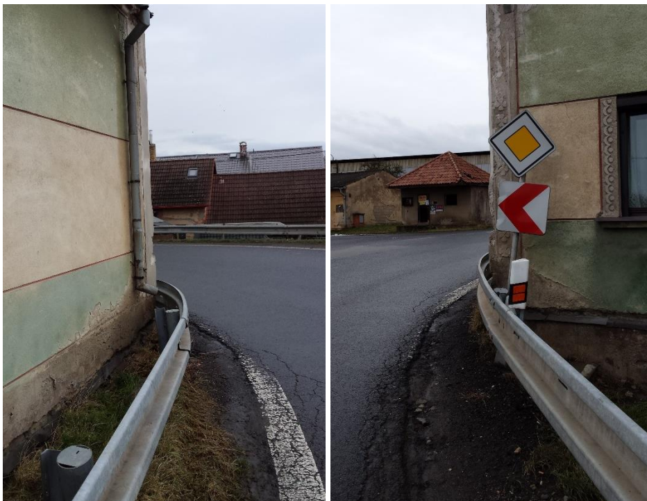
Obrázek 2 Nároží budovy s nedostatečným úzkým průjezdem [2]
