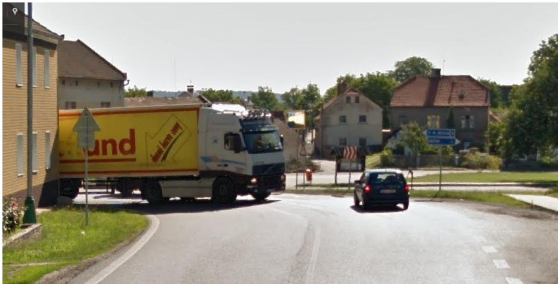
Obrázek 1 Nedostatečný poloměr oblouku pro průjezd nákladních vozidel [2]
