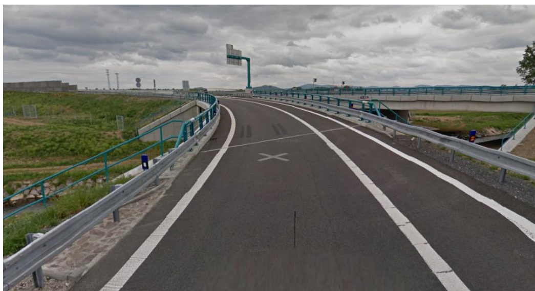
Obrázek 15 - Pohled na dálniční sjezd na R1
