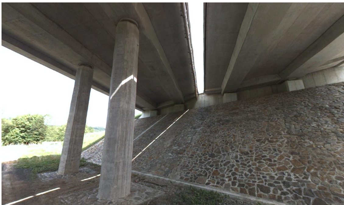
Obrázek 7 - Pohled z prostoru pod mostem
