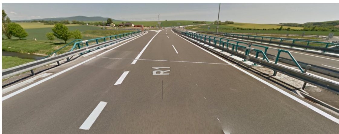
Obrázek 13 – Pohled na dálniční most přes řeku Žitavu
