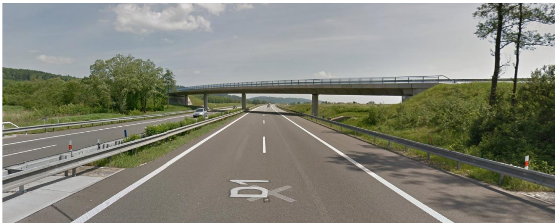
Obrázek 9 – Pohled na most převádějící silnici I/47
