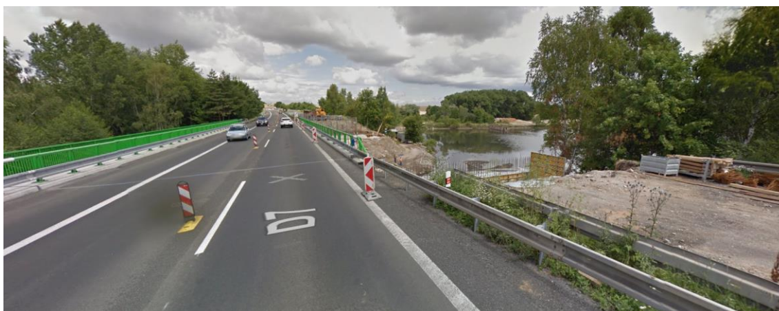
Obrázek 4 - Pohled na kompletní rekonstrukci mostu v roce 2014
