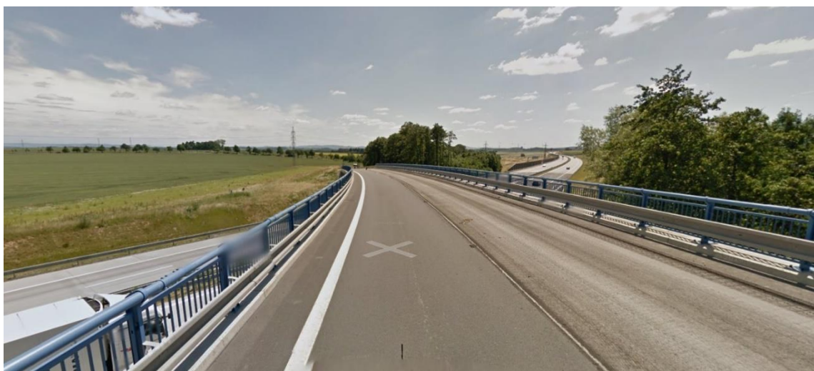
Obrázek 10 – Pohled z mostu převádějící silnici I/47
