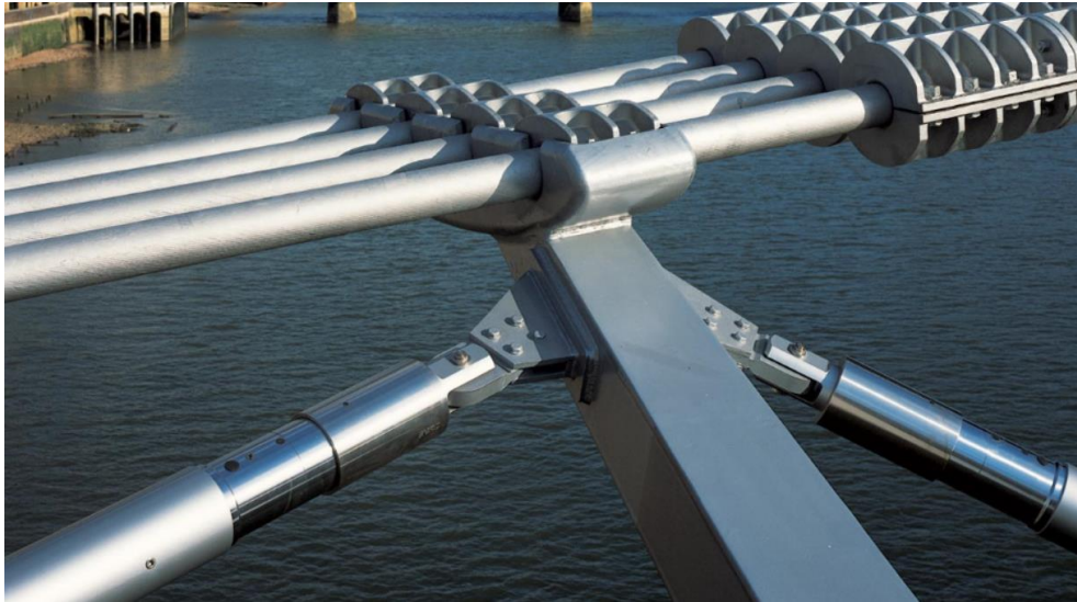
Obr. 249: Detail hydraulických tlumičů na mostě Millenium Bridge v Londýně.
