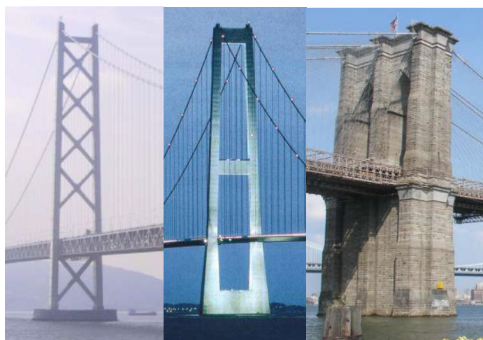
Obr. 15: Příklady pylonů visutých mostů. [18]
