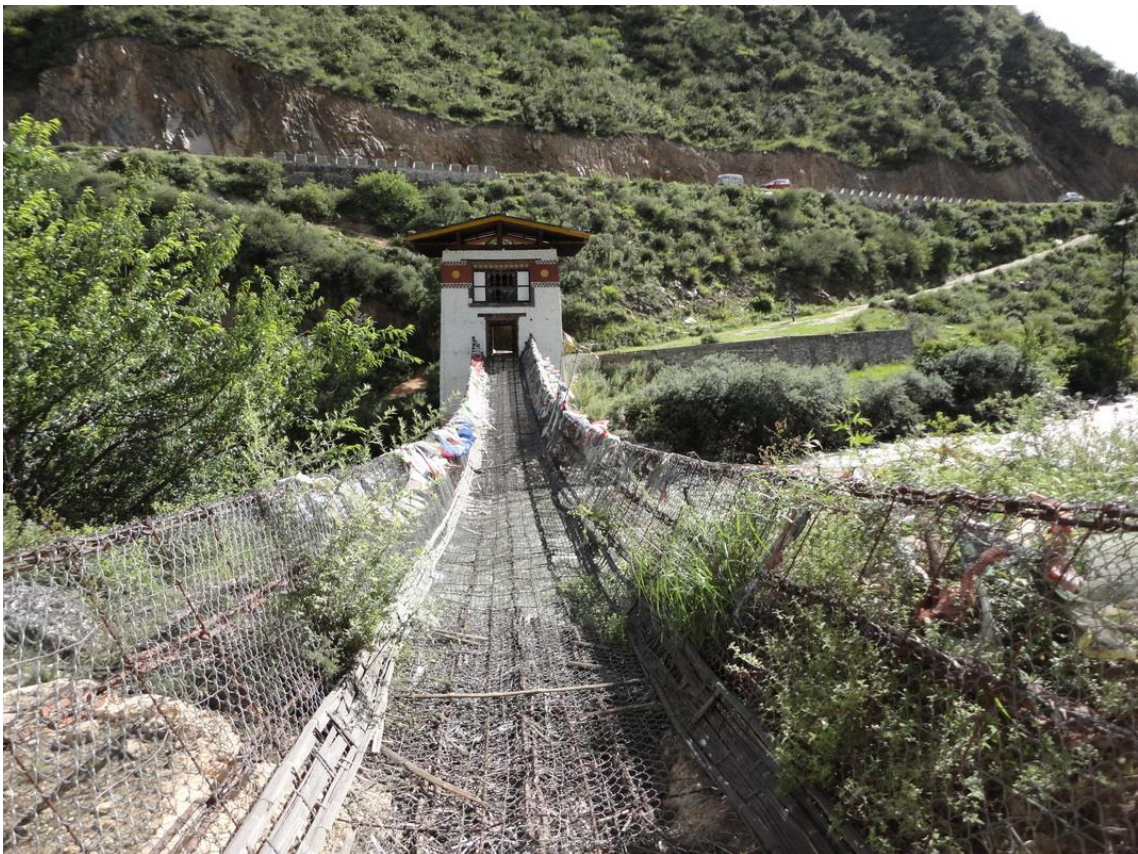
Obr. 3: Železný visutý most v Bhutánu postavený Thangtong Gyapo. [2]
