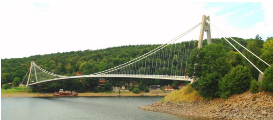
Obr. 9: Lávka přes Švýcarskou zátoku Vranovské přehrady. [9]
