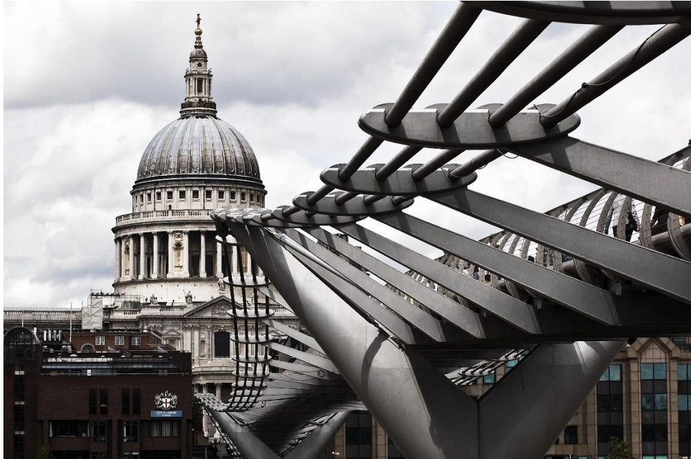
Obr. 34: Detailní fotografie Millenium Bridge v Londýně. [12]
