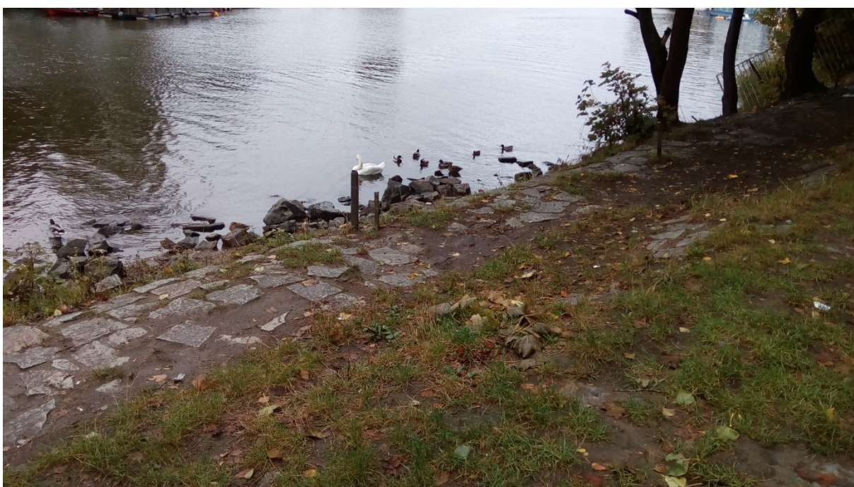
Foto 8: Další pohled na smíchovské nábřeží v místě budoucí stavby
