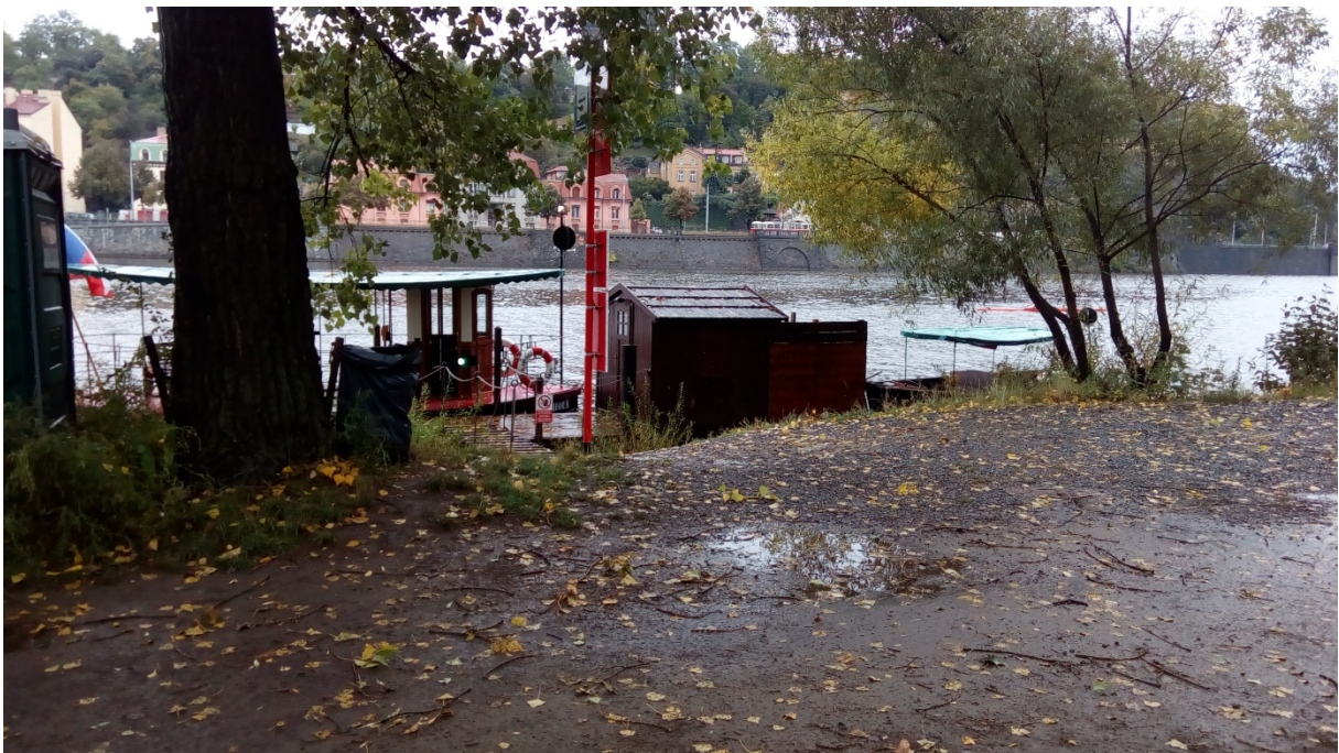
Foto 4: Stanoviště přívozu na opačné straně stezky, než bude stát lávka, z fotografie je patrný špatný technický stav stezky, jež bude rovněž rekonstruována
