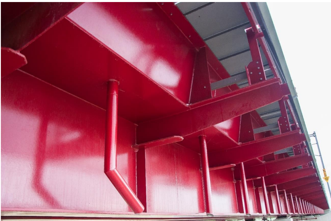
Pohled na most z boku – konzoly pro zábradlí, výztuhy NOK, odvodnění kol. žlabu
