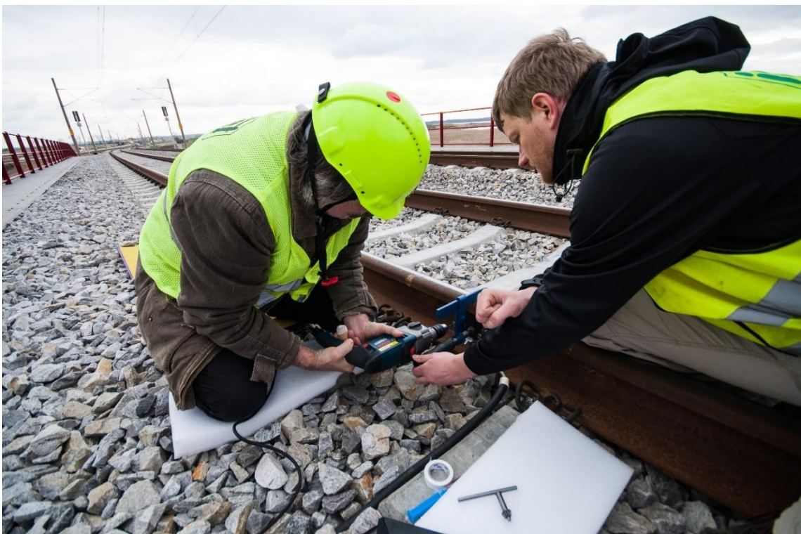
Vrtání snímačů do kolejnice
