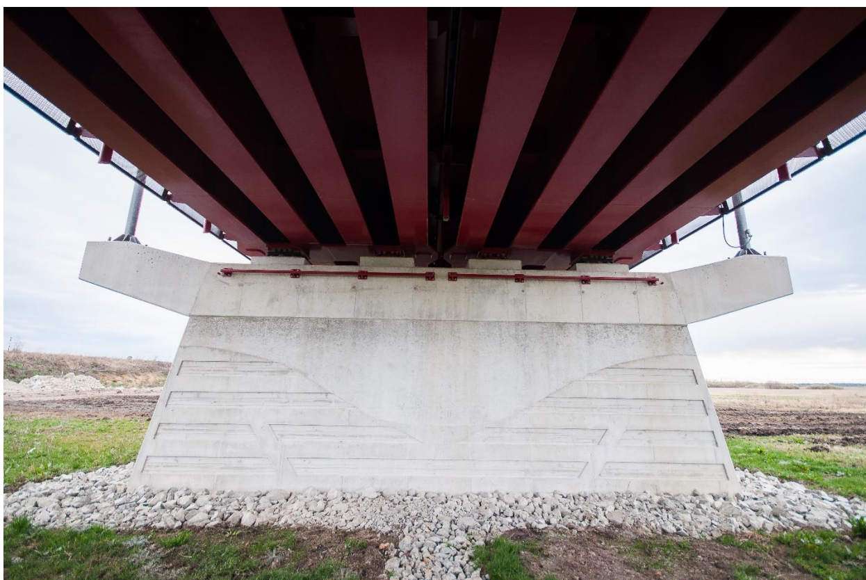
Obrázek 4: Dřík středního pilíře P2
