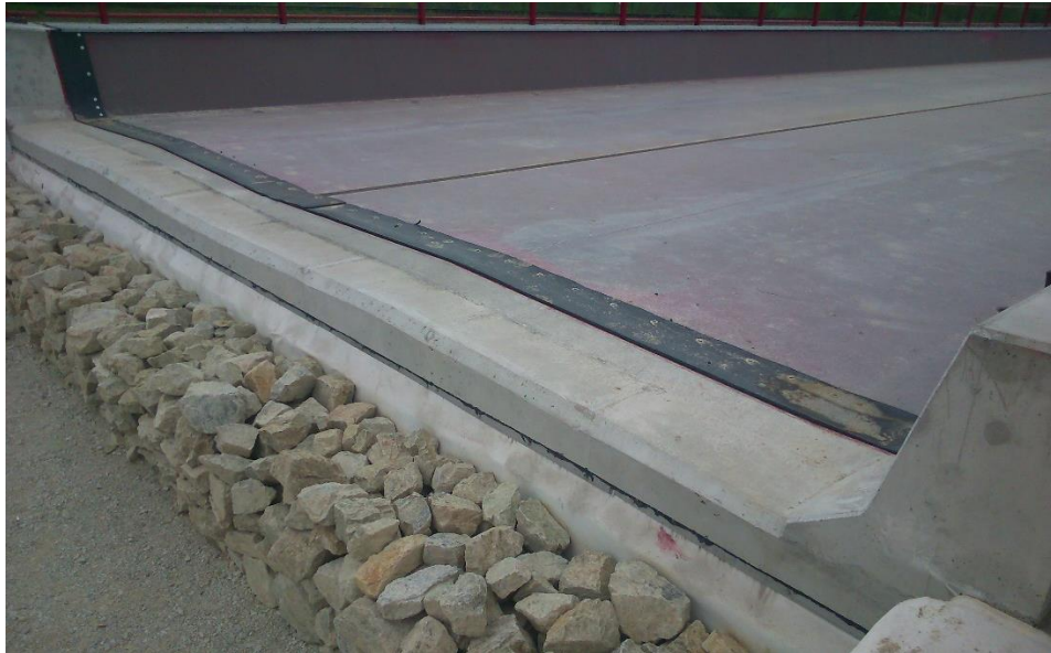
Obrázek 8. Pohled na dilatační a podélnou spáru během stavby
