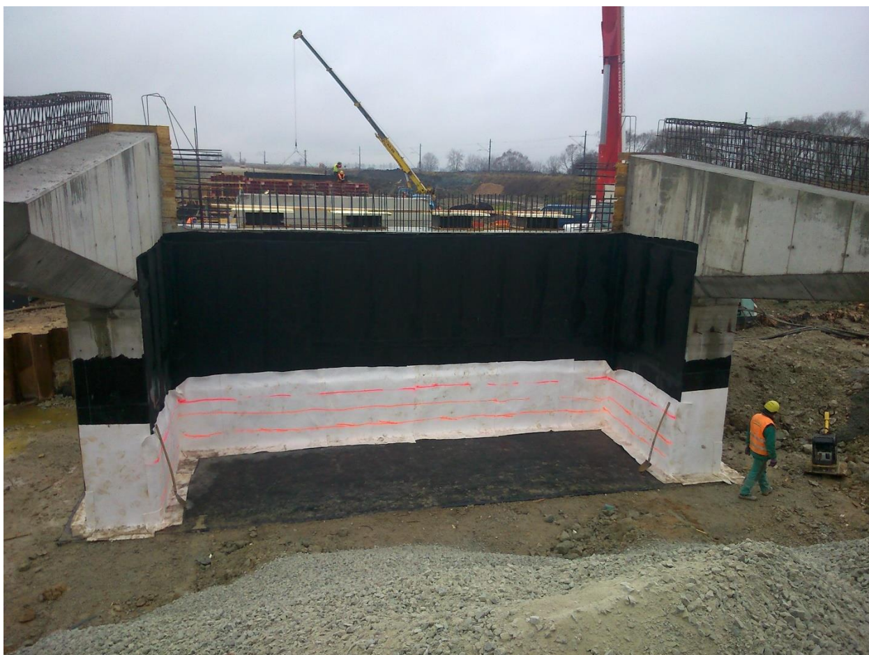
Obrázek 5: Opěra před hutněním první vrstvy zeminy, autor: Firesta s.r.o.
