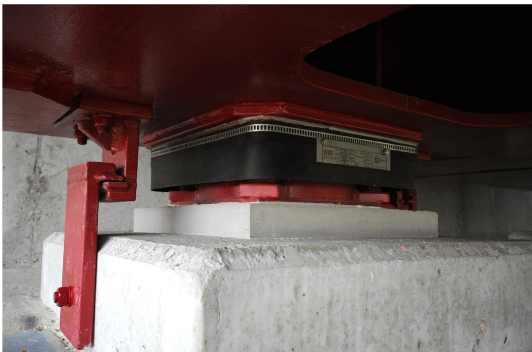
Obrázek 7: Pohled na ložisko na opěře
