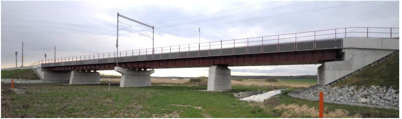
Obrázek 1: Pohled na most
