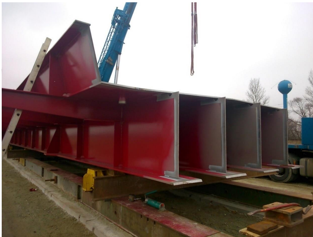
Obrázek 6: Ocelová konstrukce během montáže, autor: Firesta s.r.o.
