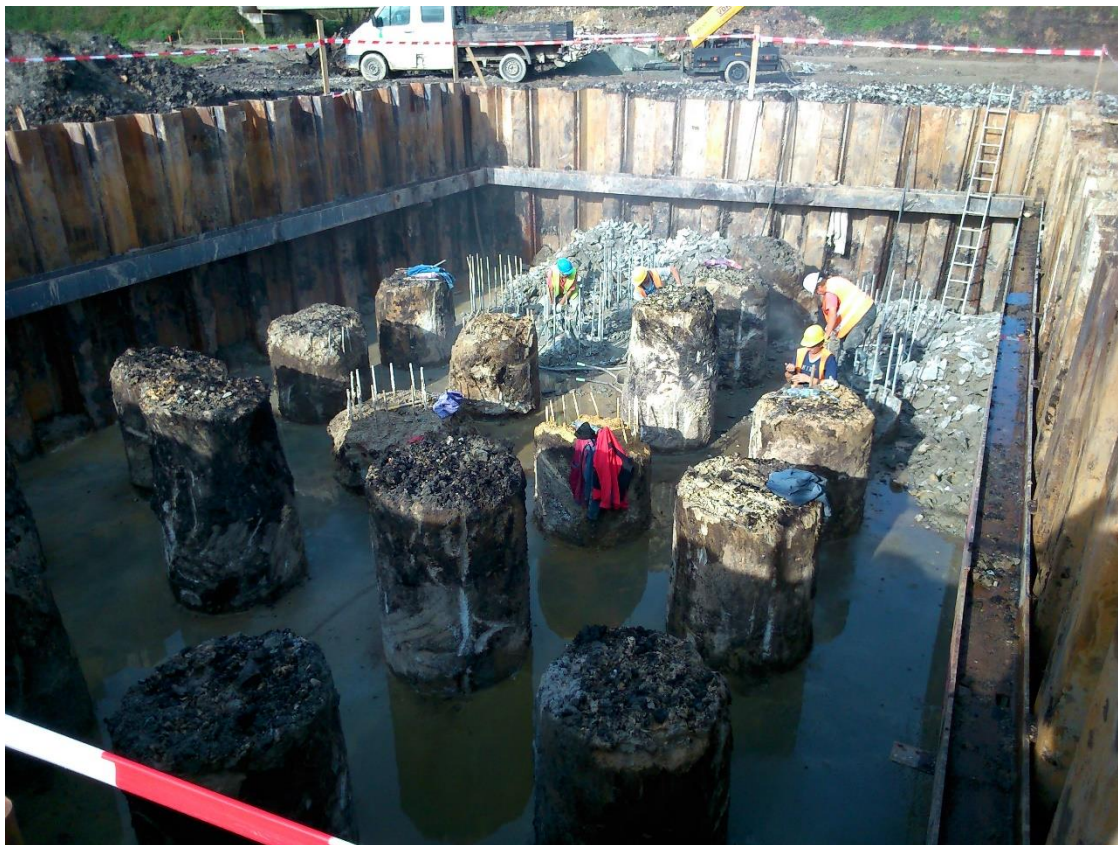
Obrázek 3: Hlavy pilot středního pilíře při odbourávání, autor: Firesta s.r.o.
