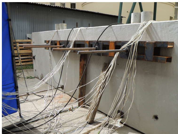
Obr. 42: Roznášecí práh v horní části čela, na fotografii jsou vidět kabely od snímačů vedoucí k měřicí ústředně
