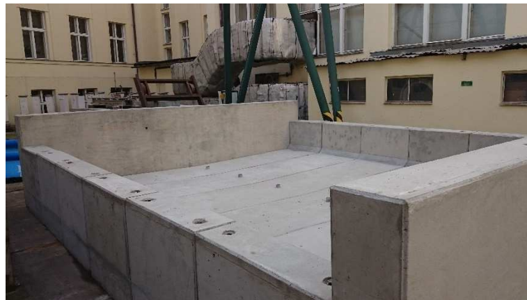
Obr. 41: Betonová konstrukce pro zřízení koleje
