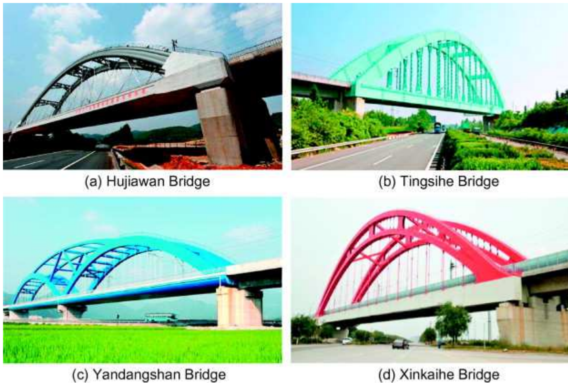
Obr. 24: Příklady obloukových mostů pro vysokorychlostní tratě v Číně [10]
