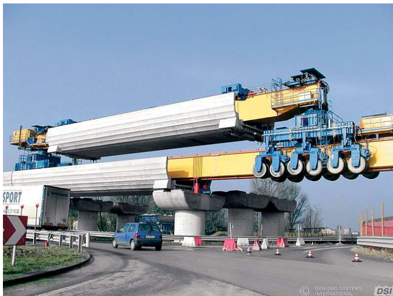
Obr. 10: Výstavba na trati Milán – Bologna z Modena nosníků (typ „f“) [5]
