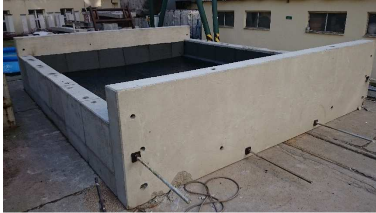
Obr. 43: Kompletní konstrukce před položením kolejového lože
