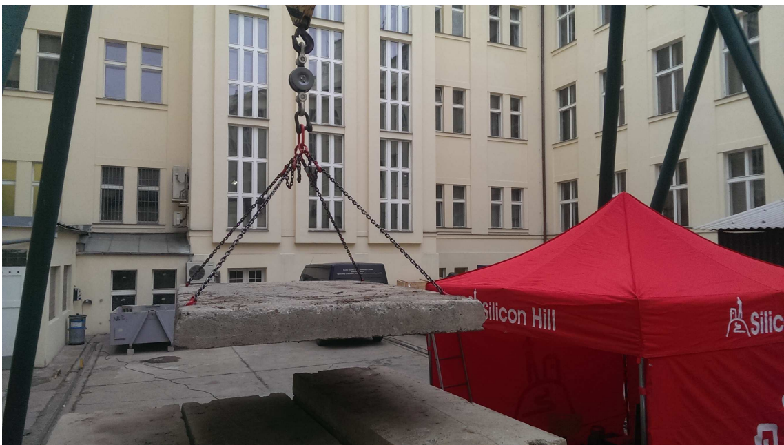
Obr. 103: Změření tíhy před položením panelu
