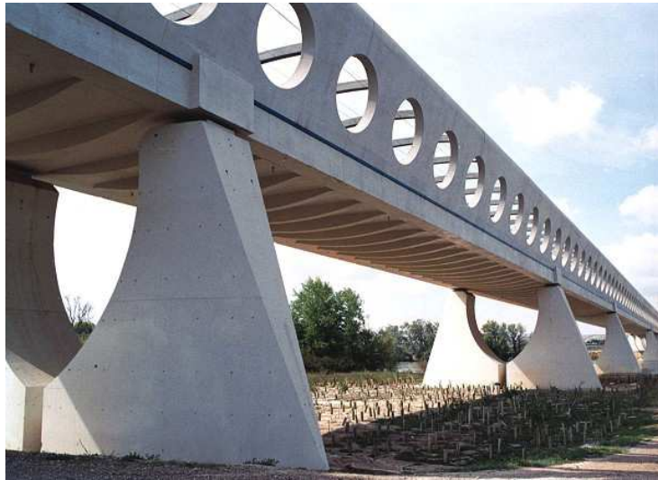
Obr. 15: Most přes řeku Ebro [6]
