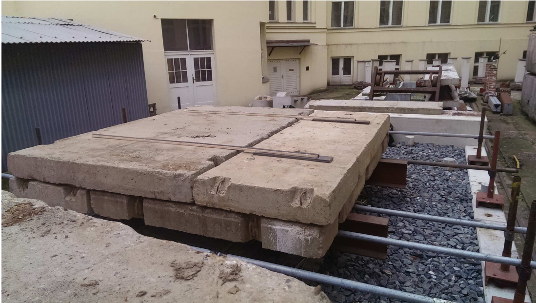
Obr. 104: Skládání panelů včetně proložení mezi vrstvami
