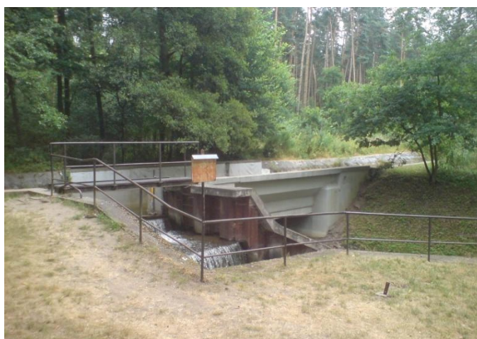
Obr. 14 Akvadukt převádějící Opatovický kanál přes Sopřečský potok
