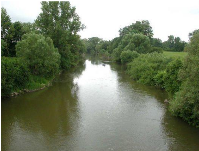
Obr. 10 Charakteristická část bilančního a odběrného úseku Hradec Králové - Sezemice (14)
