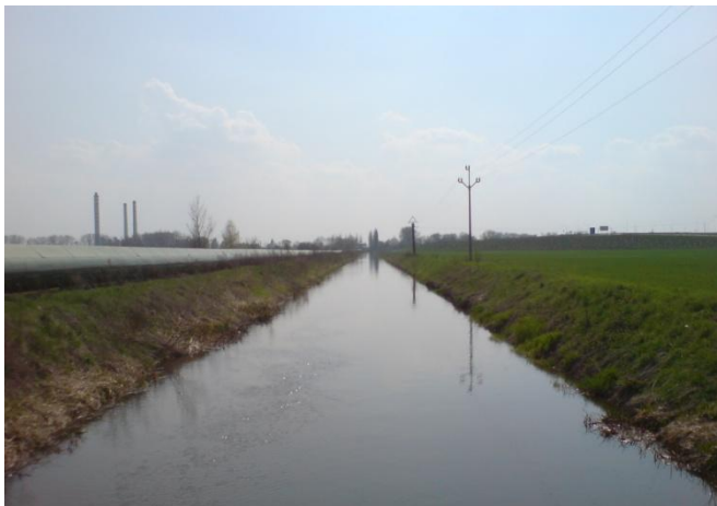
Obr. 11 Chladicí kanál Opatovické elektrárny
