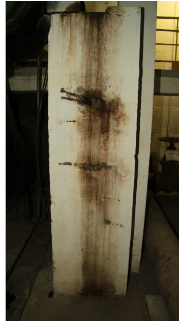
Obr. 11 – základový pilíř čerpadla M1
