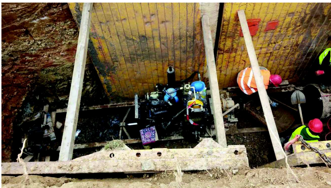
Fotografie 3.6: Neřízené ukládání ocelové chráničky za nemechanizovaného rozpojování a odtěžování zeminy
