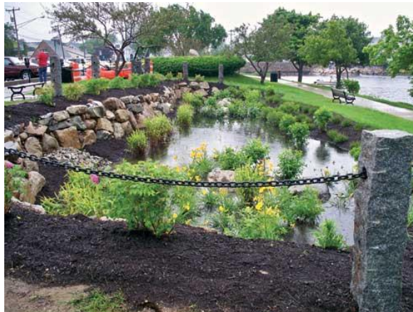
Obr. 9: Vsakovací povrchová nádrž na Rhode Islandu, USA [88]
