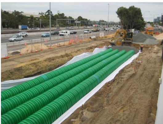
Obr. 10: Podzemní vsakovací komora Perth, Austrálie [85]
