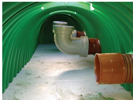
Obr. 11: Přítok do vsakovacích komor [85]
