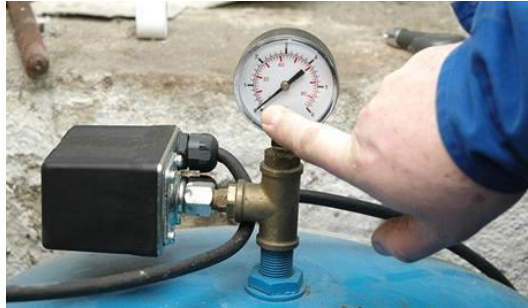
Obr. 21: Tlakový spínač s tlakoměrem [63]
