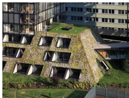
Obr. 6: Zelená šikmá střecha Centrální park, Praha [6]
